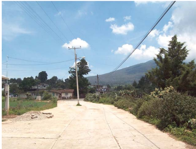
Figura 5.7 Equipamiento urbano en ausencia de un diseño urbanístico o de planeación. Generalmente el tendido eléctrico es el primero en llegar.
