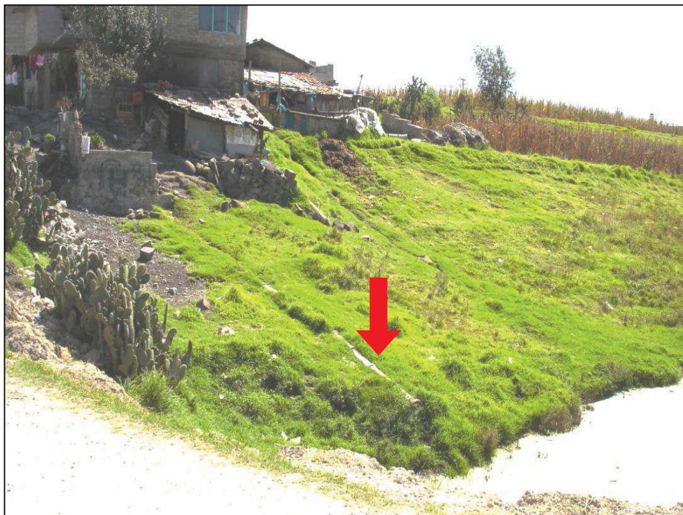
Figura 5.15 Descarga de drenaje doméstico hacia un jagüey de uso agrícola.
