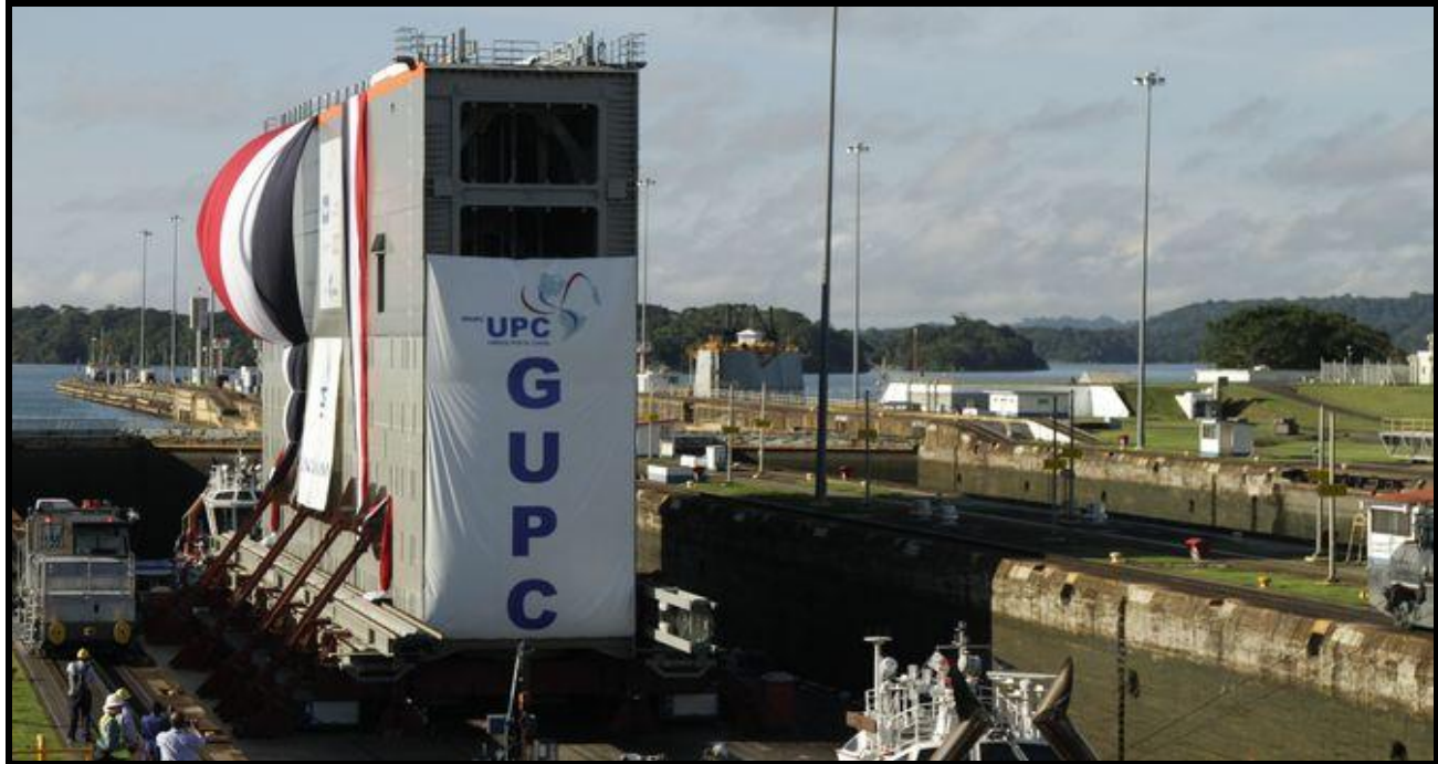
Figura 4.13 Canal de Panamá: transporte de esclusas para la ampliación, 2015.
