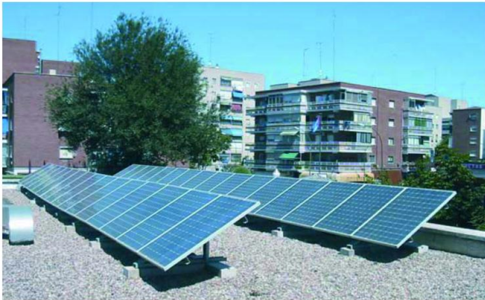
Figura 32. Instalación de paneles solares en edificios.
