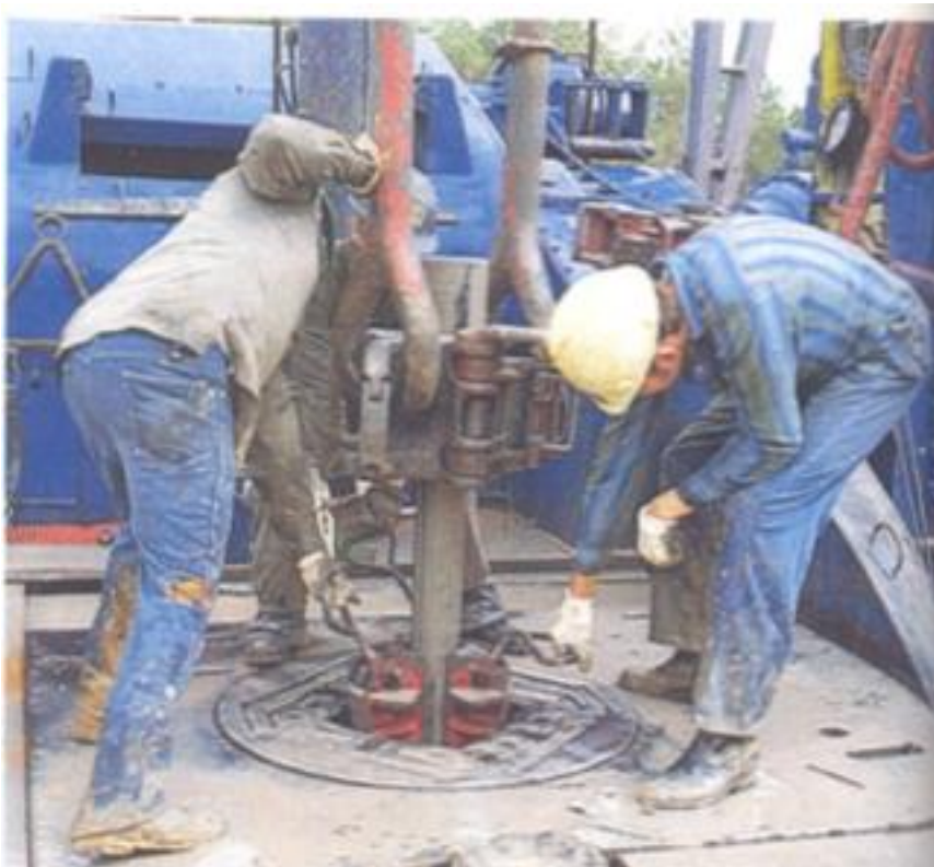
Figura 6.10 Los ayudantes del perforador meten las cuñas alrededor de una sección de tubo. Las cuñas mantiene el tubo suspendido en el agujero (20).
