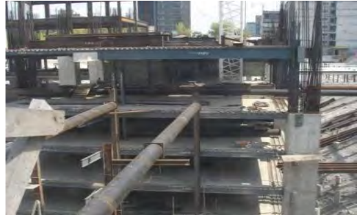
Estructura de concreto y acero
