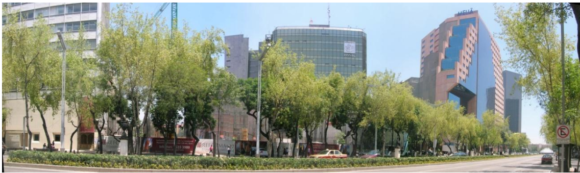
Vista del frente del terreno.
