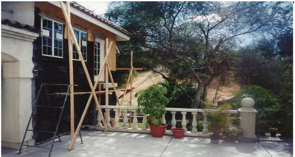
Colocación de cartón felpa color negro para impermeabilización de muros.
