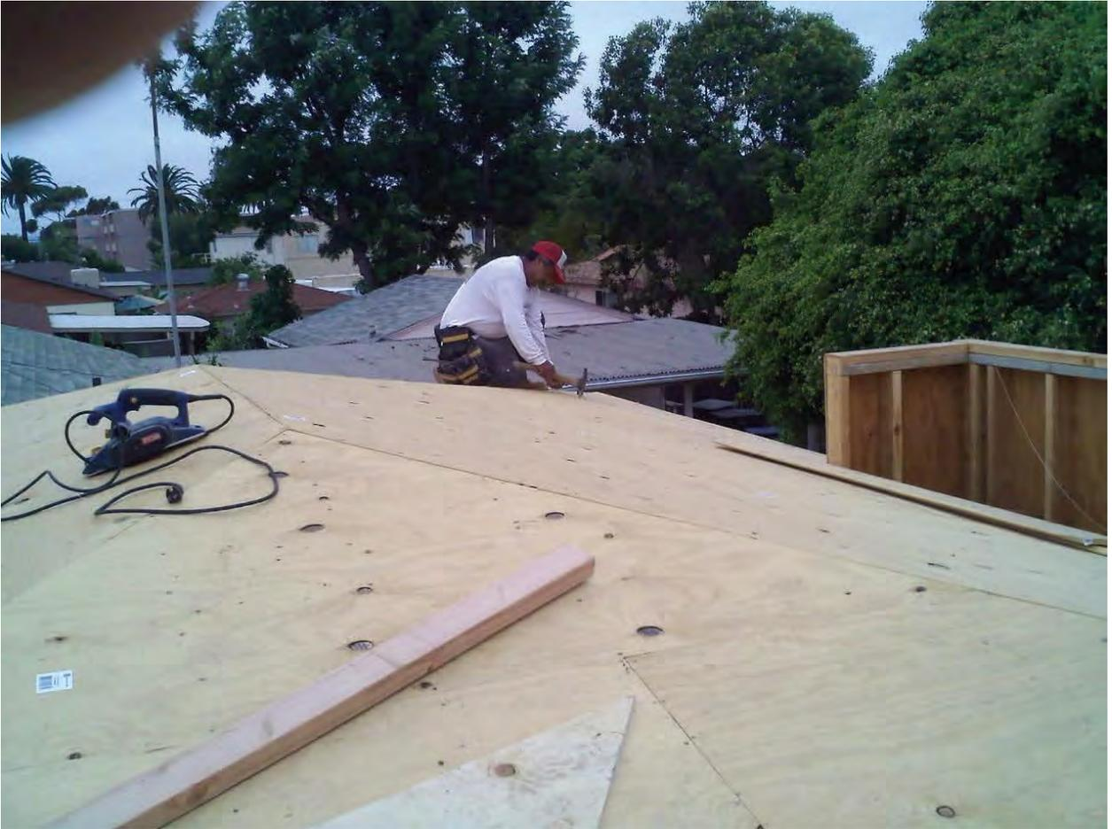
Colocación de triplay de pino CDX en Cubierta.
