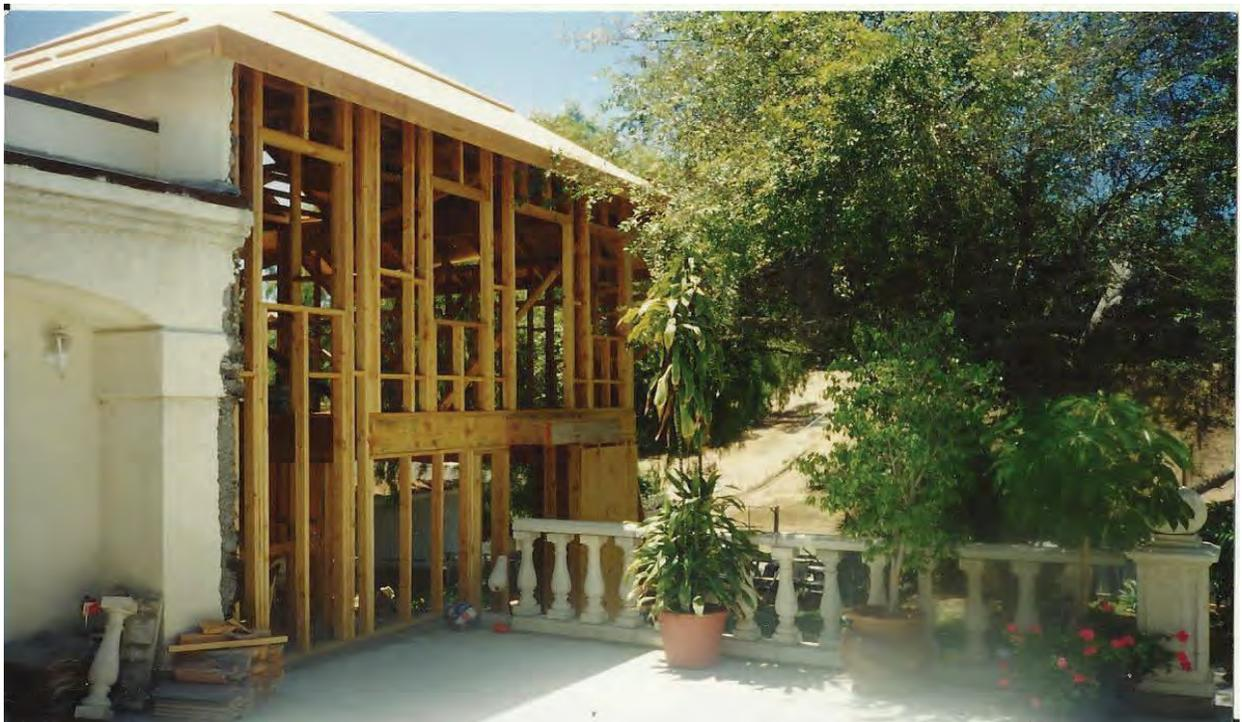
Estructura con barrotes de 2"x 4" colocados a cada 16" en muros para la Oficina y Recamara. Vista posterior.
