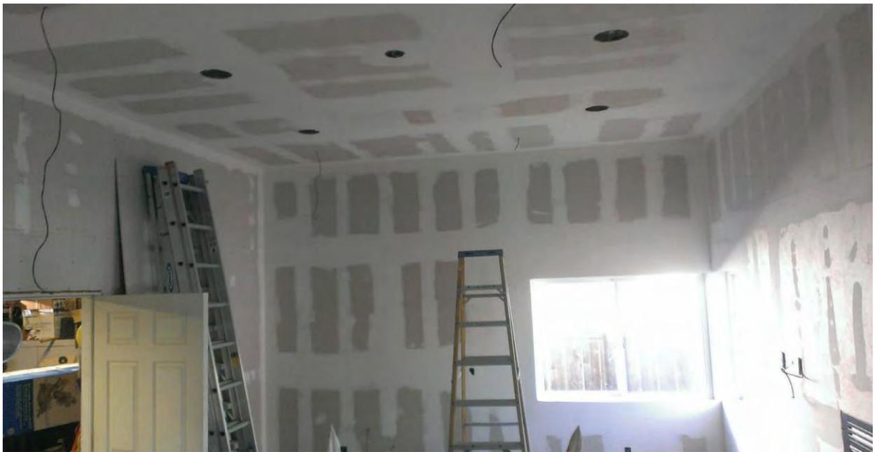
Colocación de panel de yeso de  $\frac{1}{2}$ " en muros interiores.
