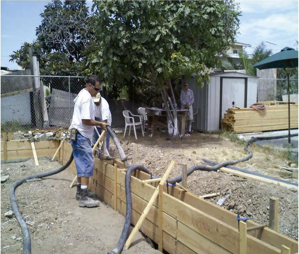
Colado de contra traves de cimentación con concreto 3000 psi. En la fotografía se aprecia la técnica de bombeo del concreto.
