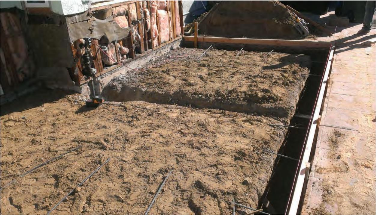
Excavación de Zanjas y colocación de Cimbras de madera para losa de cimentación de concreto armado.
