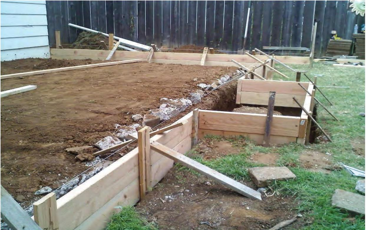
Detalle constructivo de la frontera perimetral para losa de cimentación.
