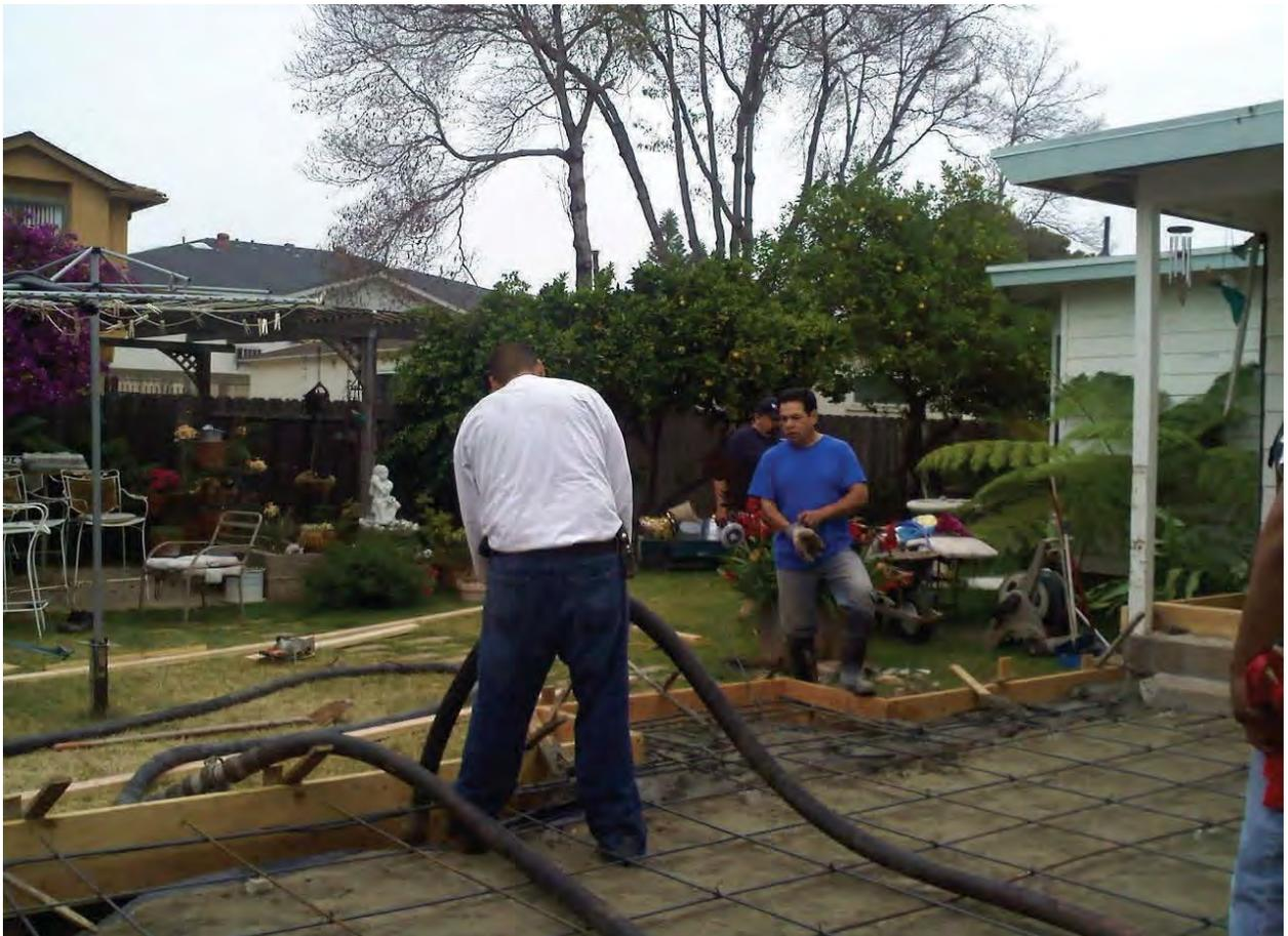
Vaciado del concreto con el equipo de bombeo especializado, tiempo de fraguado 8 horas.
