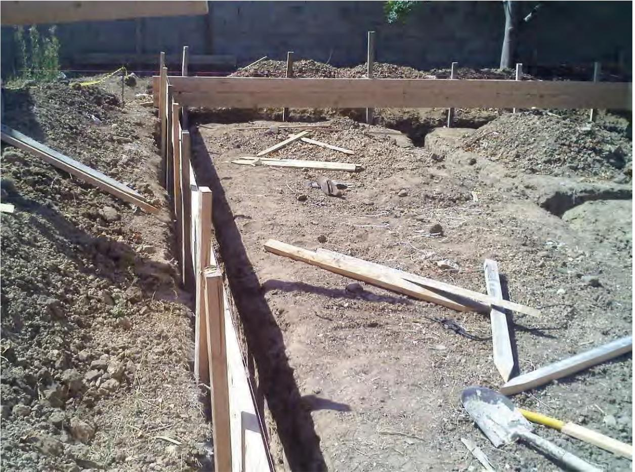
Colocación de fronteras con tablonces de 2"x 8" reforzada con puntales de 2" x 4" colocadas a cada 3' de distancia.
