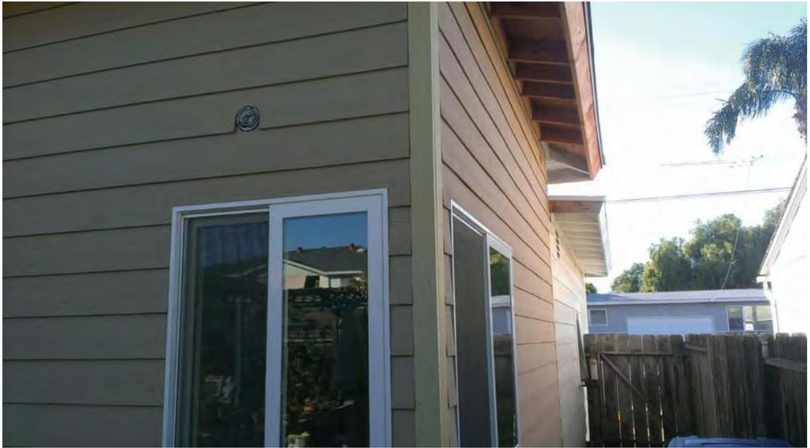
En este caso lo hacemos con madera en forma de tablas, la colocación de estos paneles de madera se hace después de haber aplicado un papel negro impermeable. Este sistema es muy práctico y mejora el aislamiento de las paredes, su aplicación es muy rápida y dura mucho tiempo.
