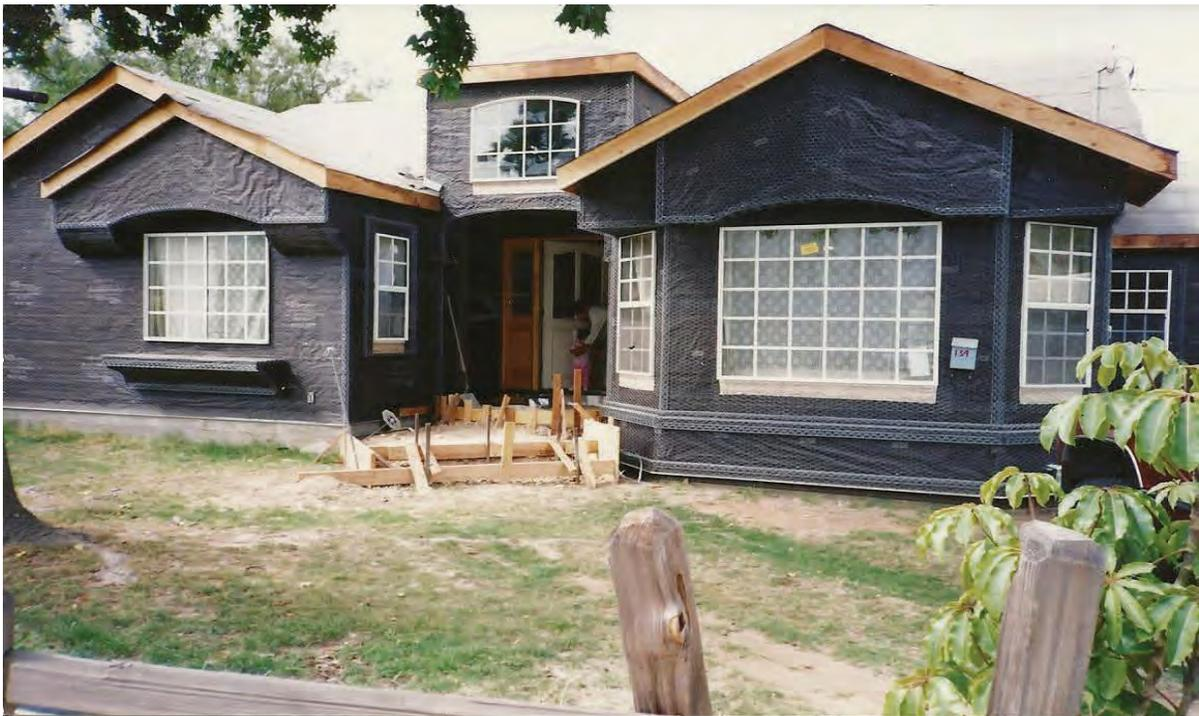
Aplicación de los Materiales de Impermeabilización en muros exteriores .
