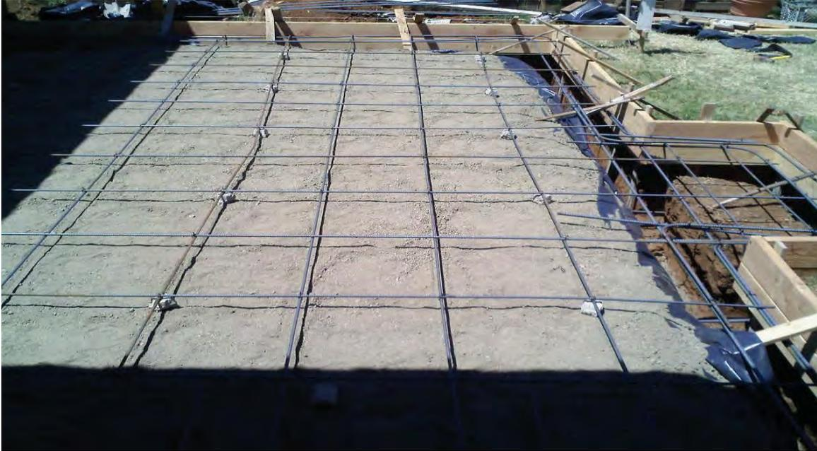
Losa de cimentación de concreto armado con varilla de 3/8”.
