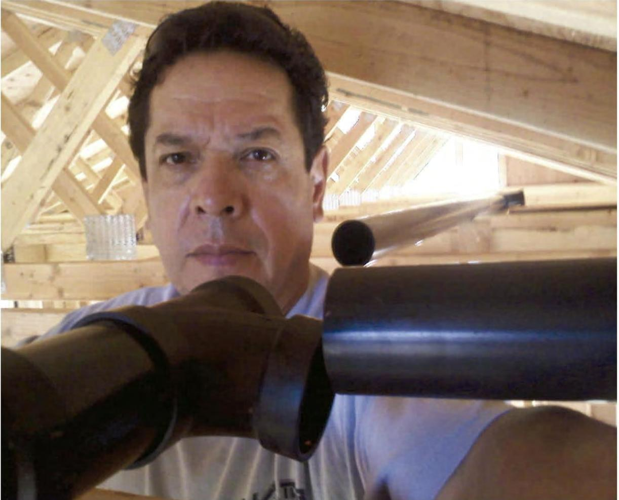
Conexiones de tubo ABS para el sistema de ventilación sanitario.
