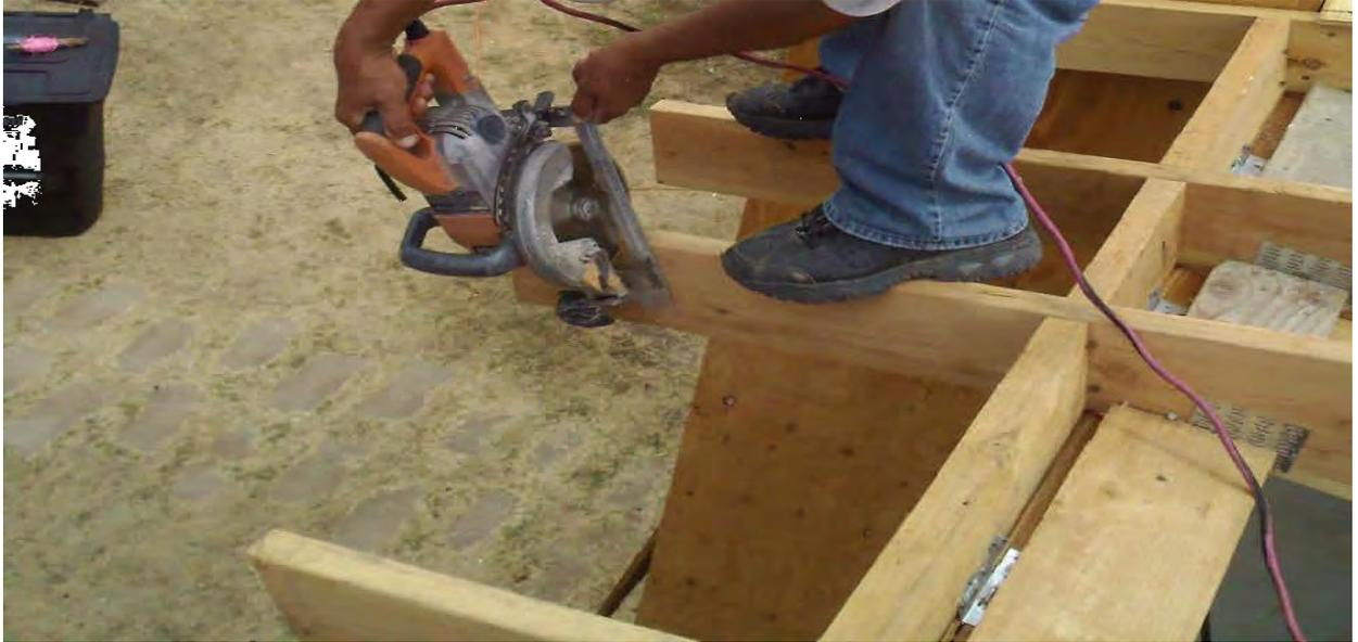
Para la instalación del alero, se cortan las puntas de los elementos que conforman el techo a una misma distancia y se coloca una tabla perimetral de 2"x6" con dos clavos galvanizados del #16 en cada punta.
