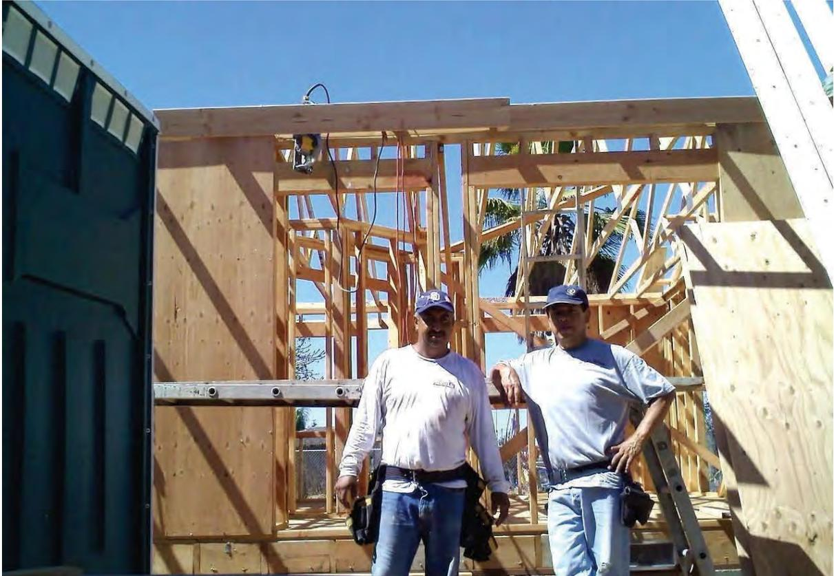
Estructura de madera en cubierta a base de barros de 2'' x 4'' x 8'.
