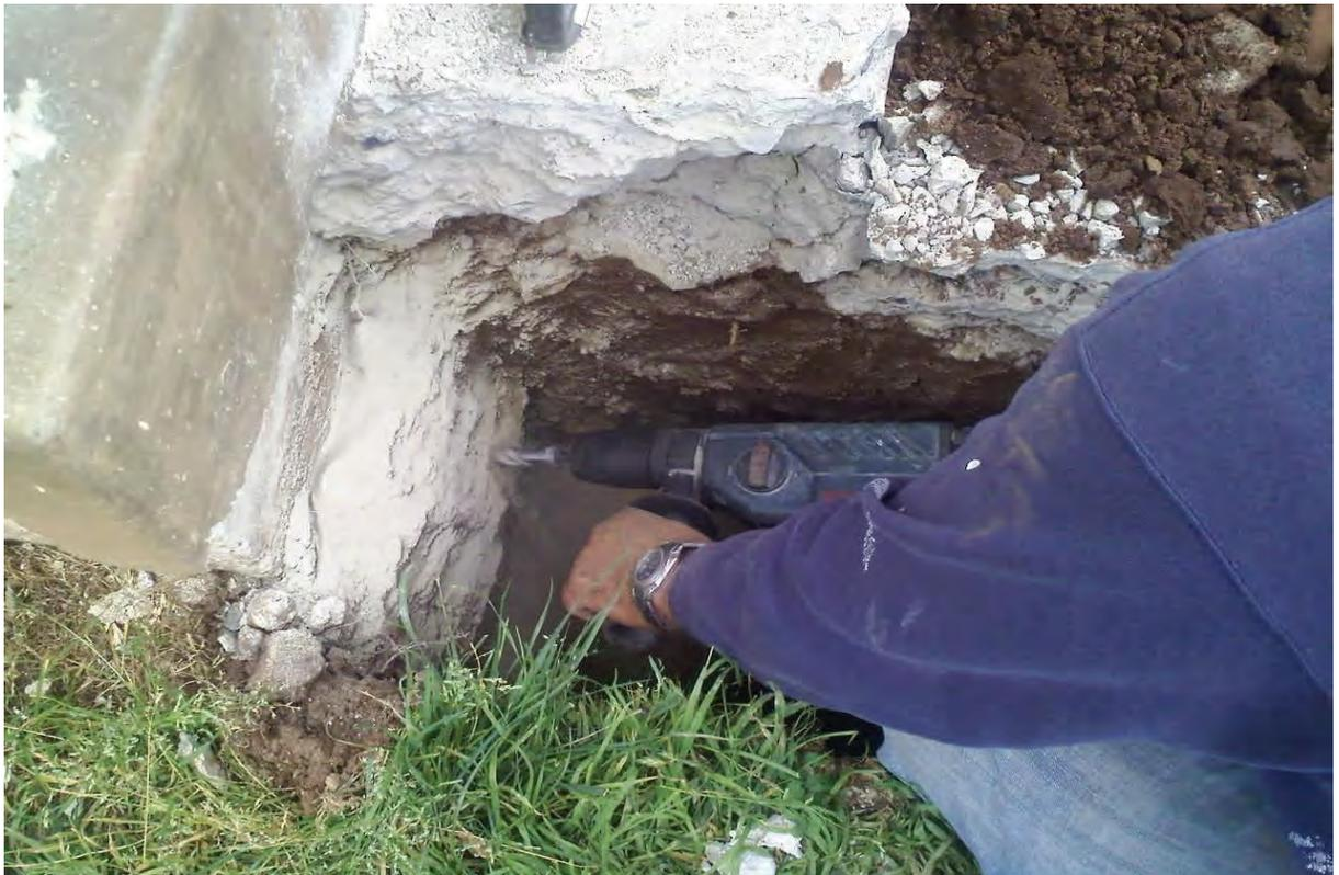
Perforación de Cimentación existente para Junta Activa.
