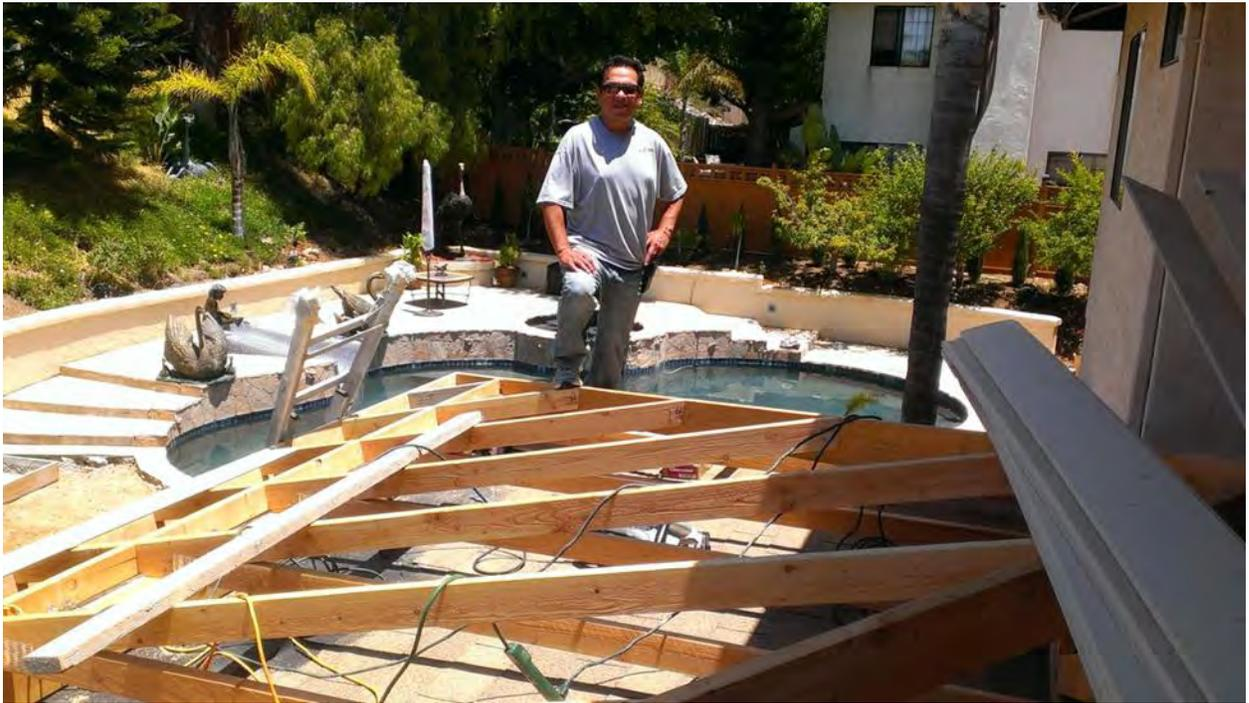
Con una cimentación más resistente se armo un techo nuevo con barrotes de 2"x4" y 2"x6" colocados a cada 24 pulgadas. Dándole más inclinación se consigue darle uniformidad al techo existente de la casa.
