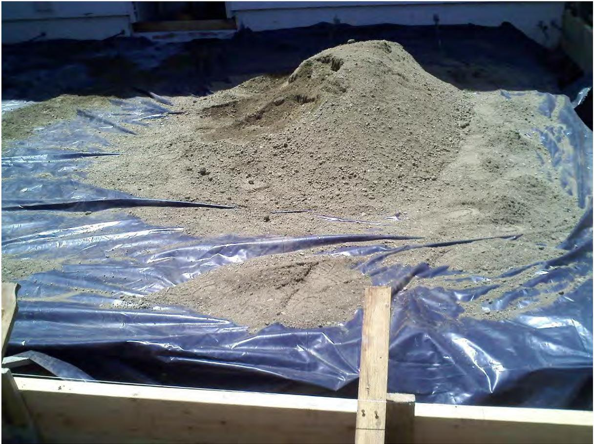
Aislamiento de losa de cimentación con plástico de poliuretano calibre 6000.
