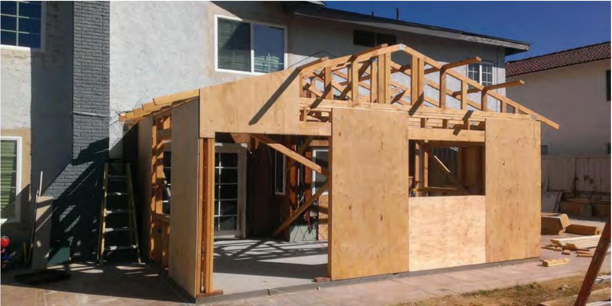
Con la prefabricación industrial de elementos o partes de una construcción para después ser montados en la obra, se reducen los plazos y el costo en la construcción. En este caso el techo es prefabricado y nos da amplias posibilidades en el claro que necesitamos. El triplay es un elemento que le da rigidez al movimiento lateral y a la vez aislamiento térmico.
