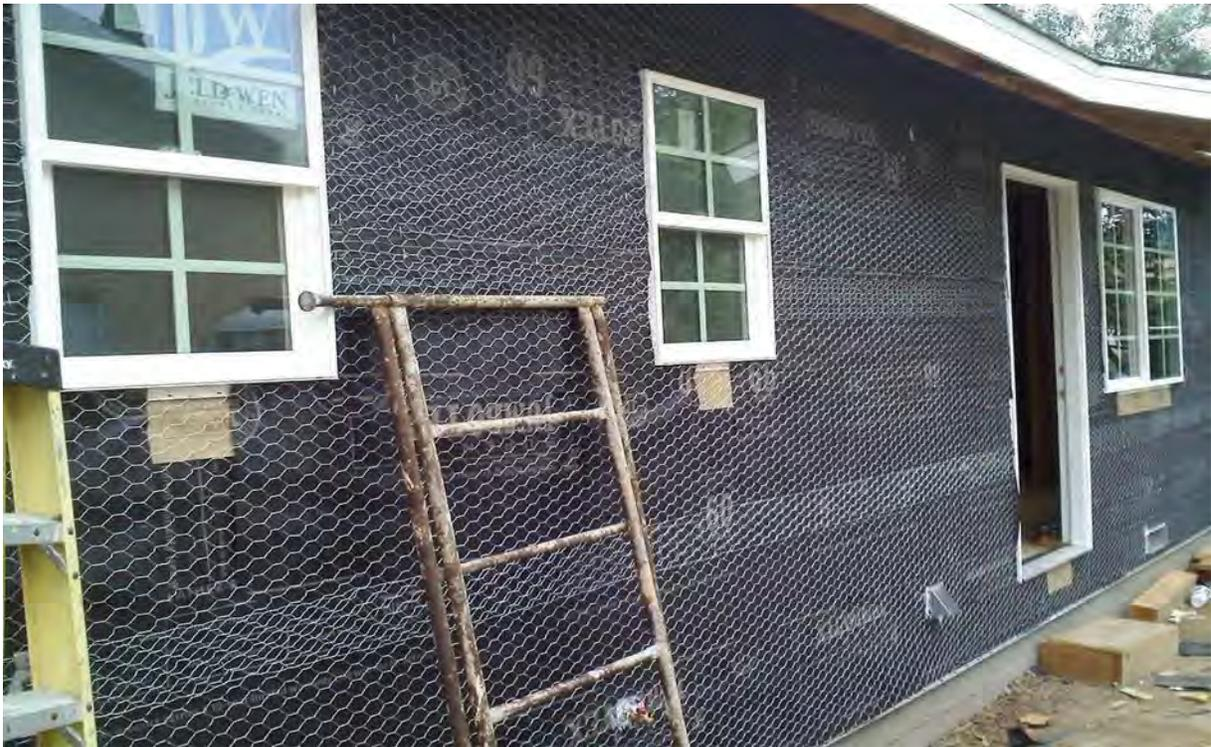
Preparación de muros exteriores con malla metálica tipo hexagonal para acabado con Mortero de Cemento- Arena
