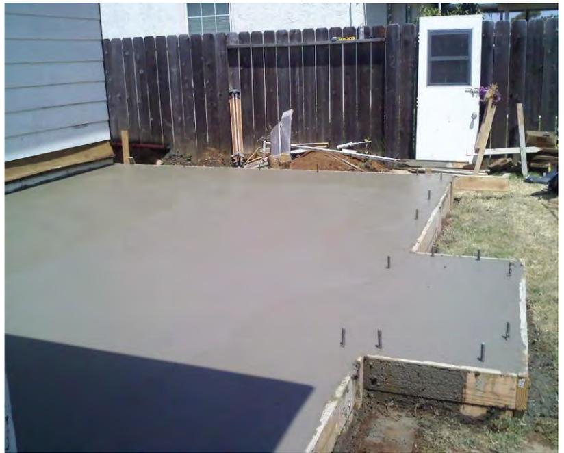
Colocado de losa de cimentación con concreto de Resistencia 3000 psi.
