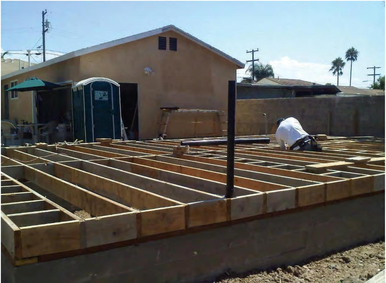
Armado de piso de madera a base de tablonces de 2" x 8" colocados a cada 16" sobre contra traves de concreto de 3000 psi. (pounds-force per square inch).
