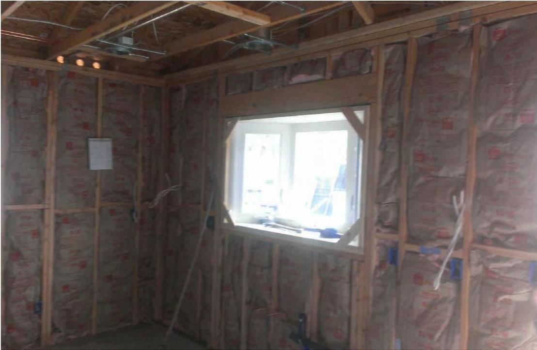
Aplicación del aislamiento después de haber sido inspeccionado el trabajo de plomería, electricidad y todos los detalles estructurales de construcción de muros y plafones.
