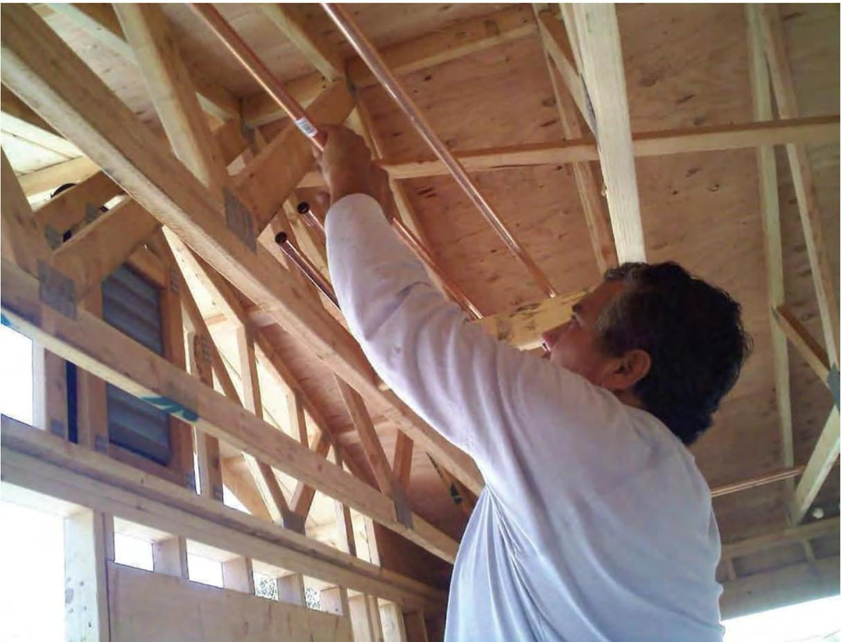
Instalación de tubería de cobre de 1/2'' para agua fría y caliente.
