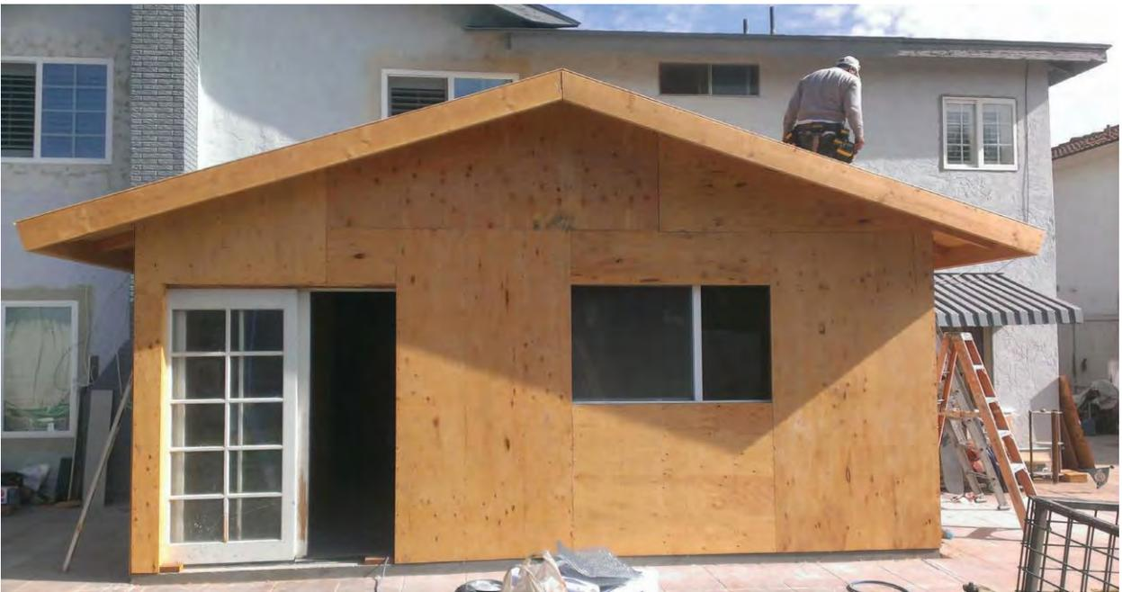
Recubrimiento con triplay estructural de 3/8" de grueso x 48"x96" fijado con clavos del #8 a una distancia mínima de 6" en su perímetro y a 12" en su interior.
