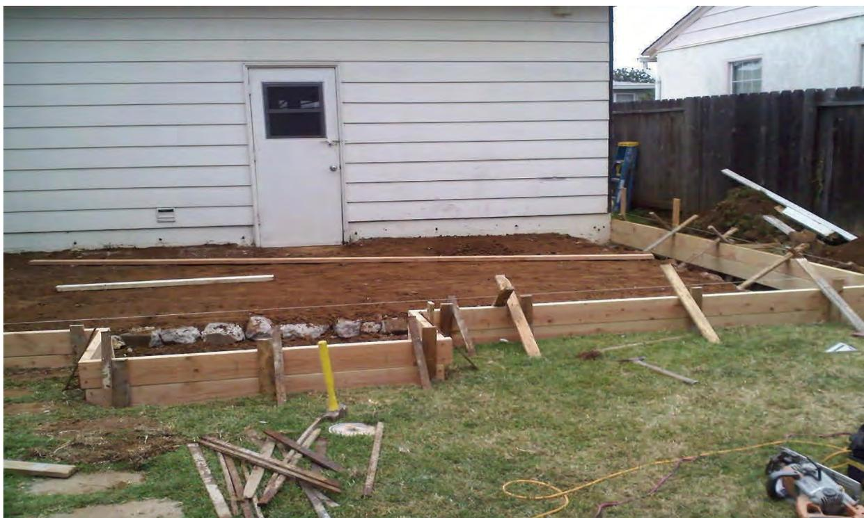
Trazo y nivelación para losa de concreto armado. Colocación de fronteras perimetrales con tabloncillos de 2"X6".
