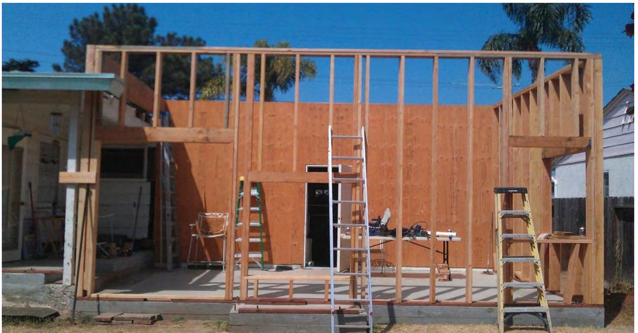
Estructura de Madera a base de barros de 2" x 6" x 10' colocados a cada 16".
