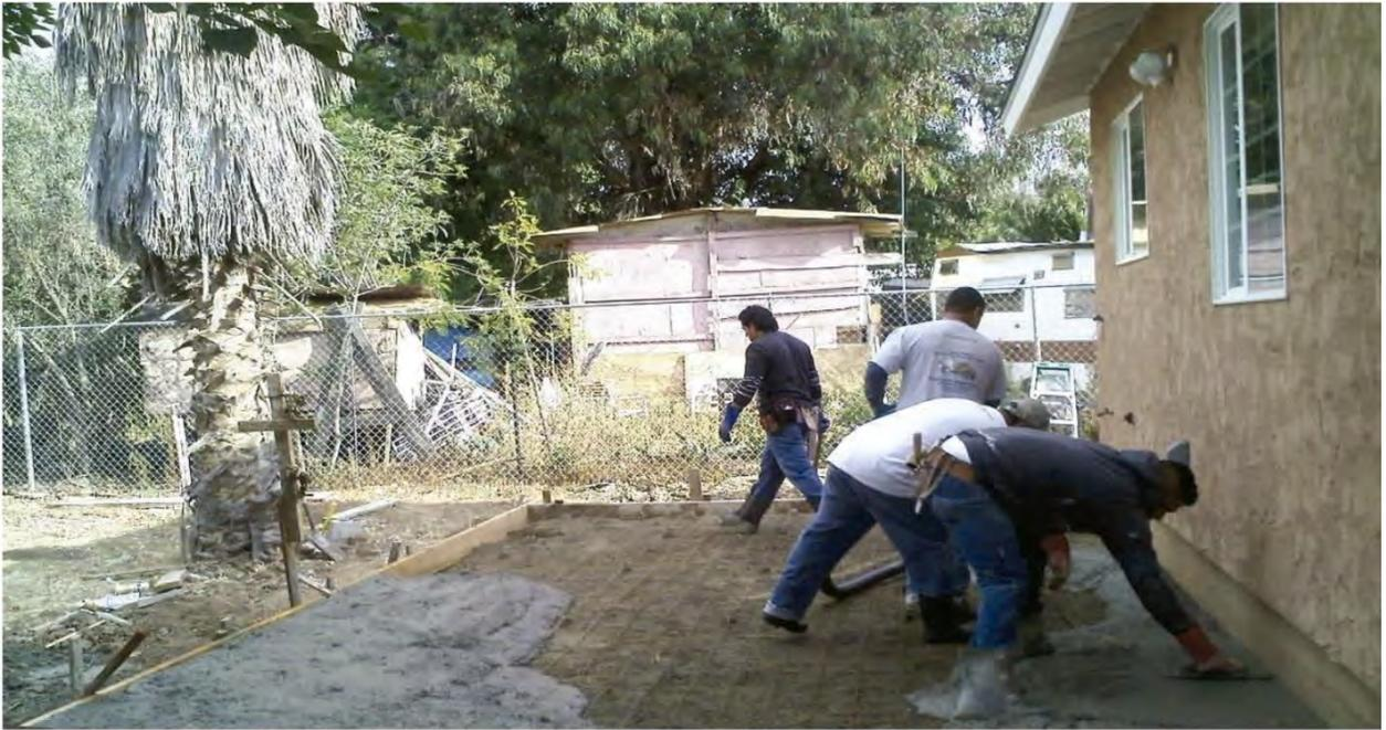
Cimbrado, armado con malla electro soldada y colado de banqueta perimetral.
