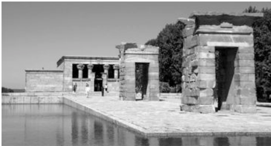
Figura 12 Templo egipcio de Debod, en Madrid. En este ejemplo se verifican tanto la restitución de elementos —sobre todo sillares de piedra— como la reintegración material a través de anastilosis para reconstruirlo en su actual ubicación.
