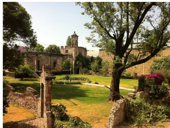
Figura 2 Fotografía actual del Pensil, visto desde la esquina suroriente del terreno.
