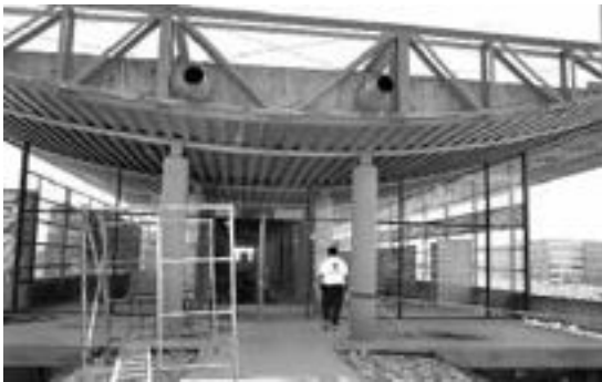
Figura 84 Vista general de la nave en proceso de construcción.
