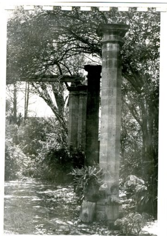
Figura 68 Columnas del corredor porticado.
