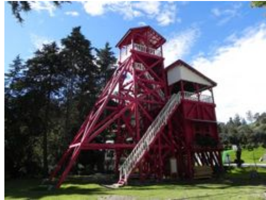
Figura 6 Tiro Norte, El Oro, Estado de México, México. Ejemplo de restitución de la torre con el objeto de darle una lectura integral al monumento. Aunque la torre desapareció en el s. XX, el material documental existente permitió la reconstrucción fidedigna.
