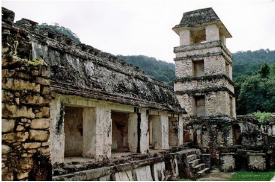
Figura 11 Palenque, Chiapas. La torre —único ejemplo conocido en el mundo maya— fue reintegrada a partir de las piezas halladas al pie del basamento; pese a la inexistencia de evidencia documental, se reconstruyó según la estimación y tipo de piezas halladas.
