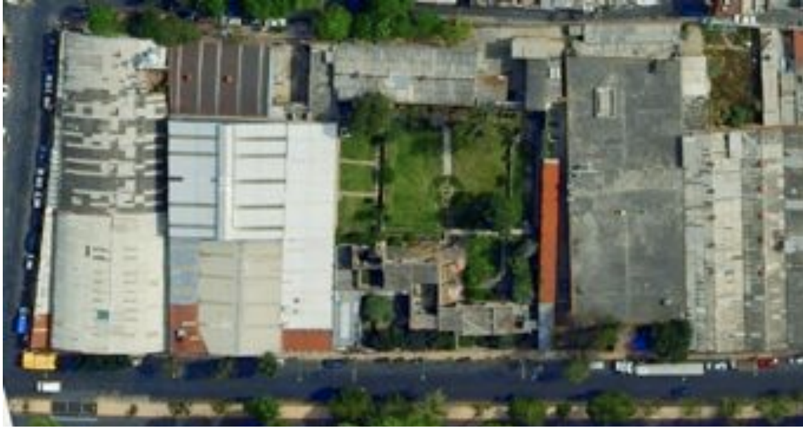
Figura 70 Imagen satelital del Pensil. Obsérvese la parte construida (con pérdida de cubiertas) y la bodega aledaña al norte.
