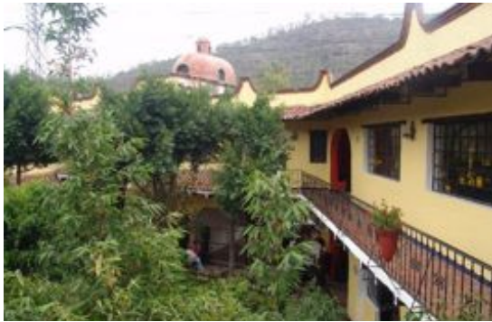
Figura 78 Vista del corredor en planta alta.
