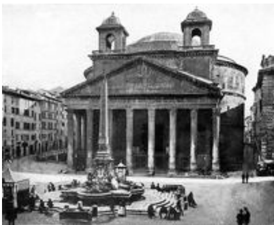
Figura 10 Panteón de Agripa. Nótese la existencia de las dos torres campanario agregadas por Bernini en el s. XVII y retiradas como obra de liberación del monumento.
