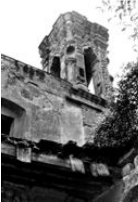
Figura 52 Estado actual de la torre campanario.
