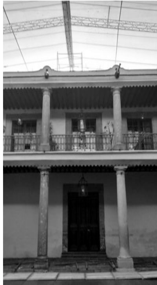
Figura 25 Vista interior del patio
