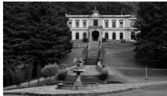
Figura 18 Fachada del Manicomio General de La Castañeda. El inmueble originalmente construido en Mixcoac fue demolido en 1968 y sólo su fachada fue reedificada en Amecameca, Estado de México, gracias a la acción del Ing. Bernardo Quintana Arrijo.
