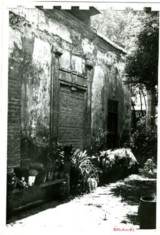
Figura 62 Vanos tapiados en la parte oriente del edificio.
