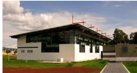
Figura 90 Edificio complementario, talleres.
