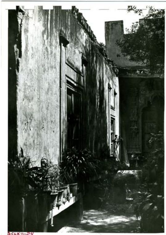
Figura 58 Vista de la fachada interior del edificio. Nótese la preparación del corredor cubierto.
