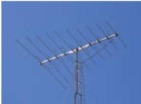
MMDS o TV VÍA MICROONDAS: La señal viaja a través del aire y llega a los televisores de los hogares mediante una antena receptora. Se requiere de antena transmisora por ciudad. MMDS. Siglas en inglés MMDS (Multipoint Multichannel Distribution System), o Sistema de Distribución Multicanal Multipunto.
