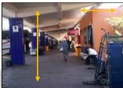
Cubierta estructura metálica. (fig. 35)
