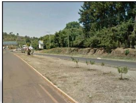
Carretera a la Huacana (fig. 23)
