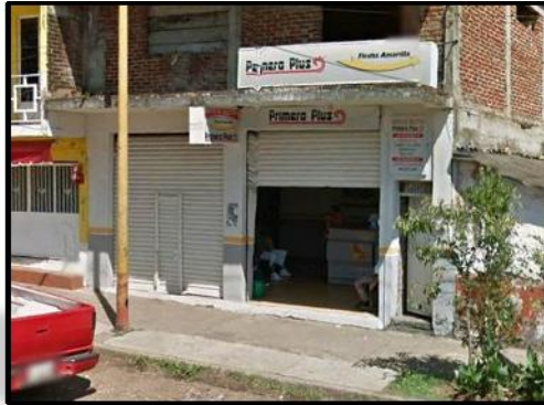
Actual instalación, dentro de local comercial (fig. 13)
