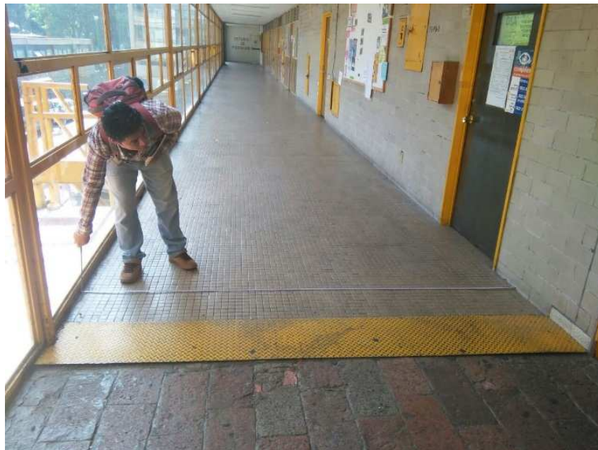
Figura 4-4 Medición del área de pasillo planta baja
