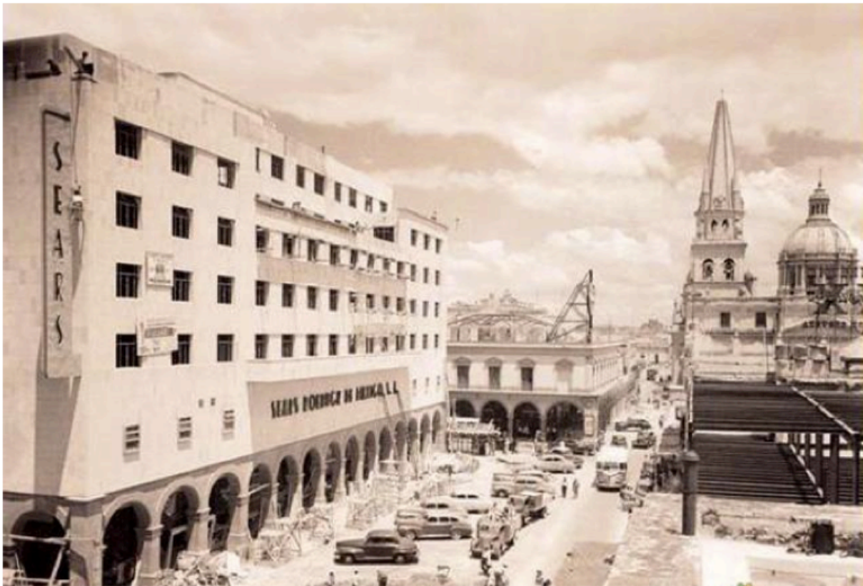
Imagen 2. 2 Obras de demolición en el Municipio de Guadalajara, 1950.
