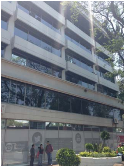
Imagen 31. Fachada principal del caso de estudio.
