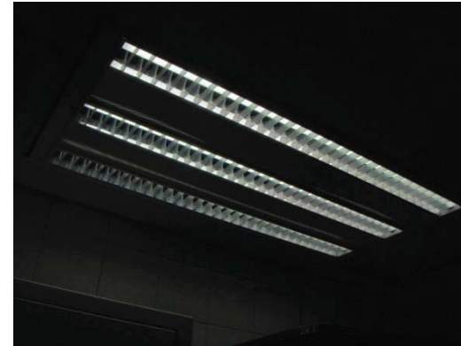
Imagen 38. Luminarias T5 3x14 W
