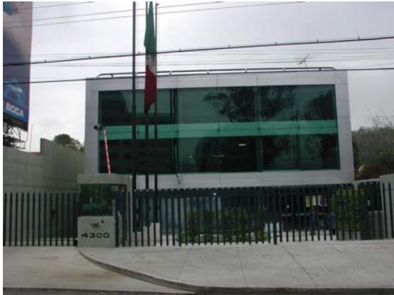
Imagen 34. Fachada principal del caso de estudio.
