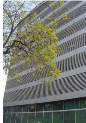
Imagen 57. Fachada principal del caso de estudio.
