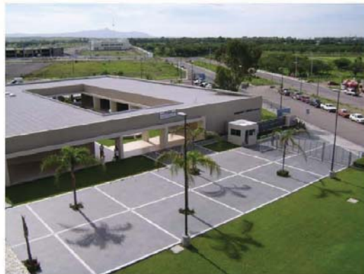
Arriba: Estacionamiento, Hospital León Guanajuato.
