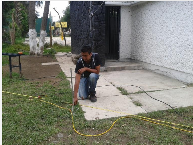
Figura 21. Colocación del cable inteligente
