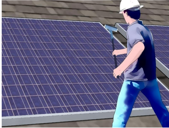
Figura 3.4.5 Profesional de limpieza de paneles solares (Wikihow, 2014)
