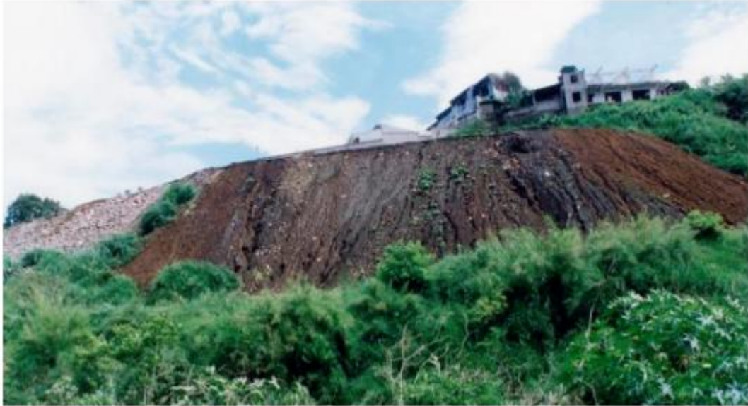
Figura 2.3.1.: Deslizamiento producido por la saturación del suelo. Además puede observarse la inclinación de los árboles respecto de la vertical, lo que hace pensar que se encuentra bajo la presencia del fenómeno creep.
