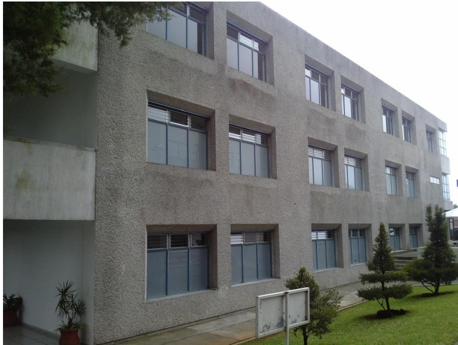
Imagen 4.13 fachada lateral principal, edificación 3 niveles. (Fuente: propia)
