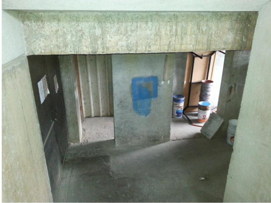
Imagen 4.19 Sótano de edificio en investigación. (Fuente: propia)
