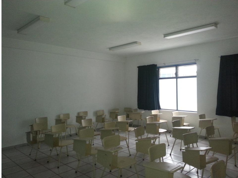
Imagen 4.18 Instalaciones interiores de aulas (Fuente: propia)
