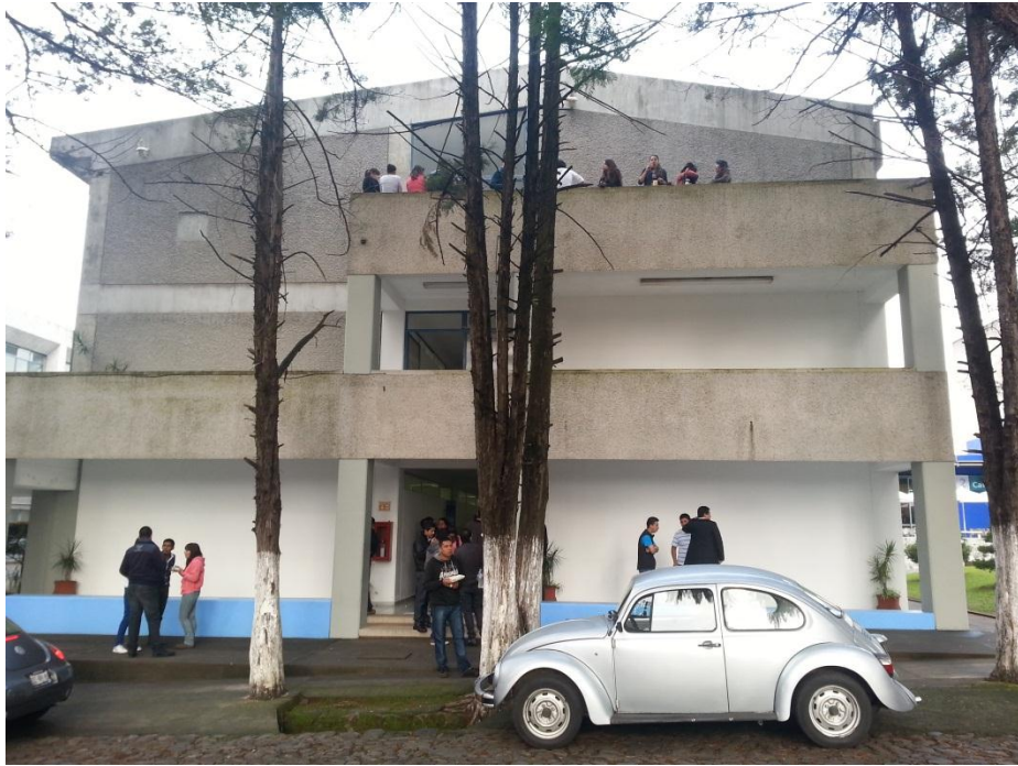
Imagen 4.10 Fachada principal frontal del edificio en estudio. (Fuente: propia)
