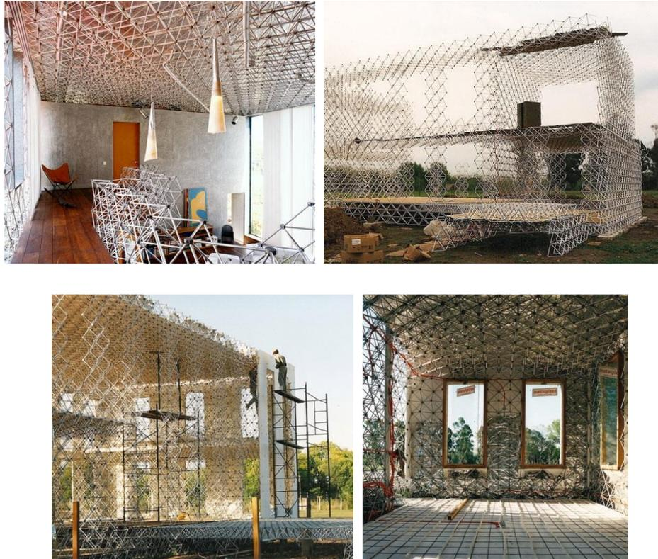
**Figura 42.** Sistema estructural Molecule, aplicado en la construcción de una vivienda (Buenos Aires).
