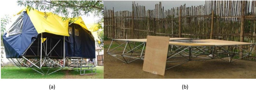
**Figura 40.** Proyecto de vivienda de emergencia en Ecuador. (a) Vivienda armada; y (b) plataforma de apoyo de vivienda.
