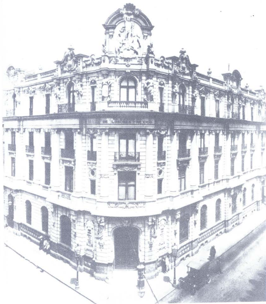
Edificio del Banco de Londres y México, antes de su reforma.
