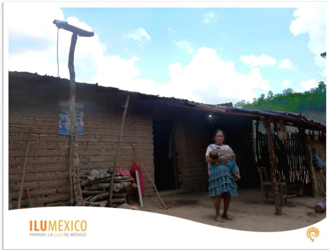
Figura 4.8 Equipo fotovoltaico instalado (Illuméxico, 2012).
