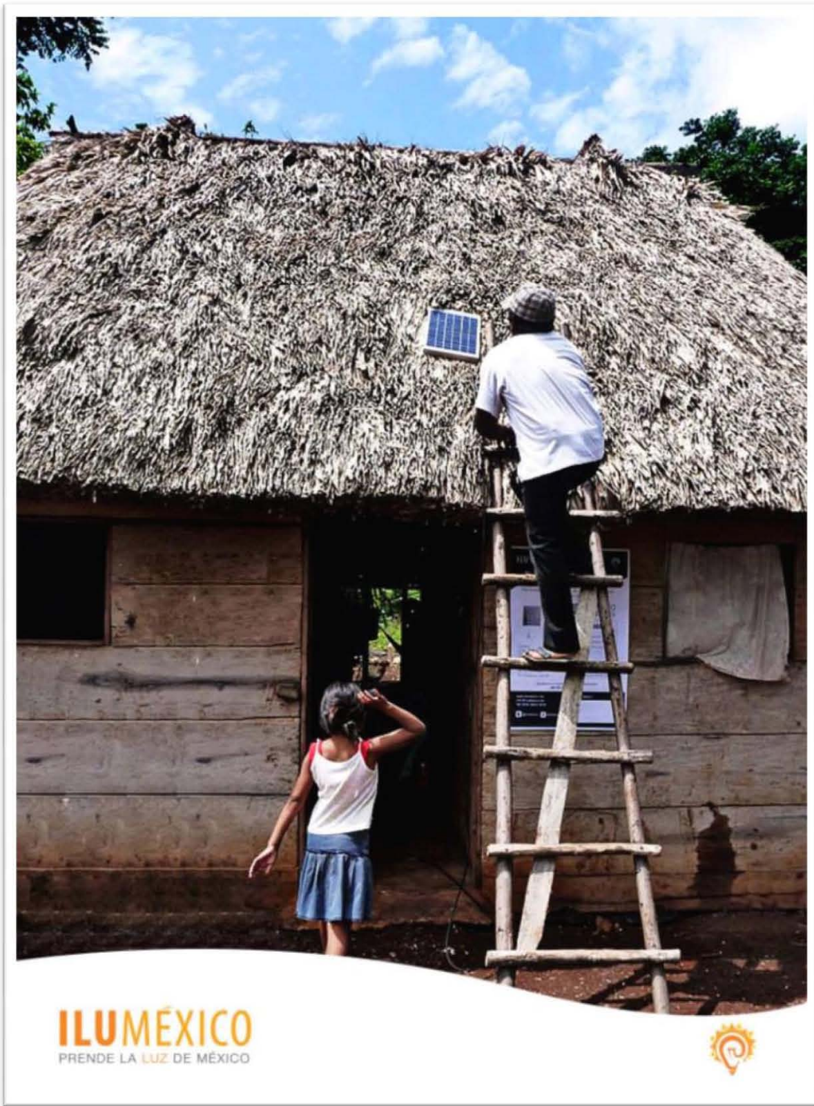
Figura 4.7 Instalación del equipo fotovoltaico (Illuméxico, 2012).
