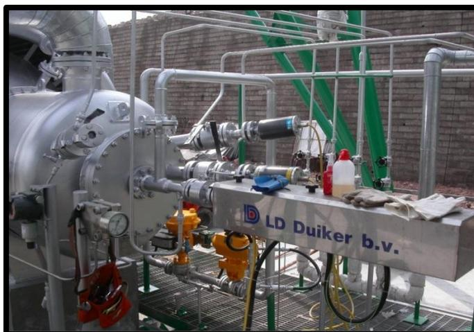
**Figura IV. 3 Instalación en Campo de un Quemador Duiker.**
