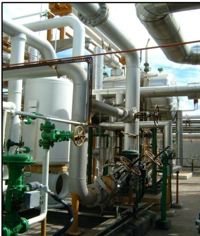
Figura III. 1 Válvulas de control existentes.
