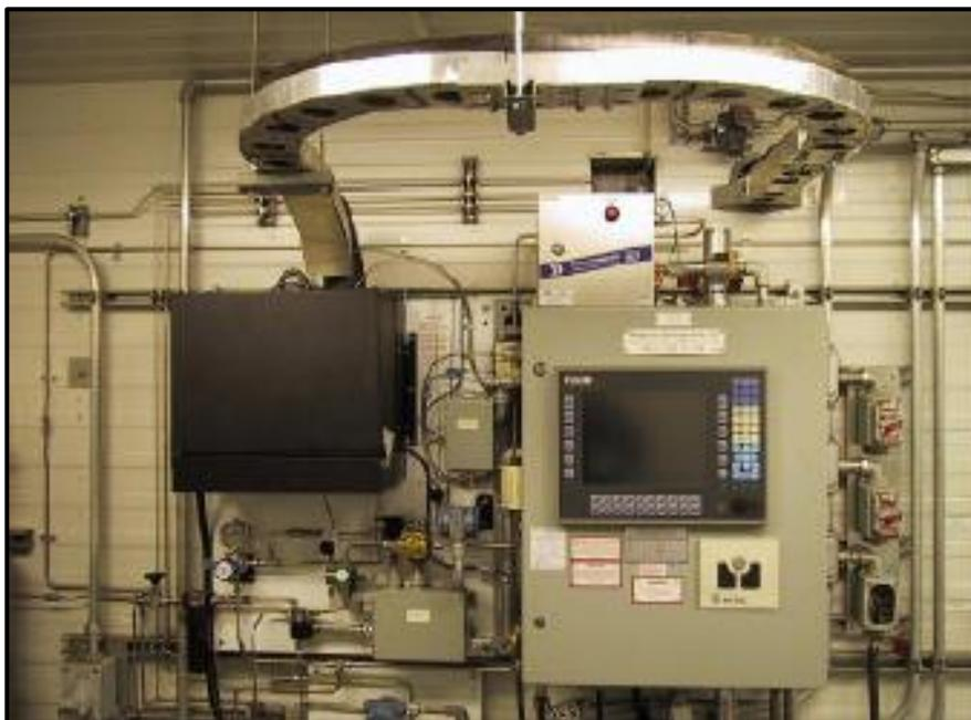
**Figura IV. 1** Esquema de Instalación de un analizador modelo Brimstone.
