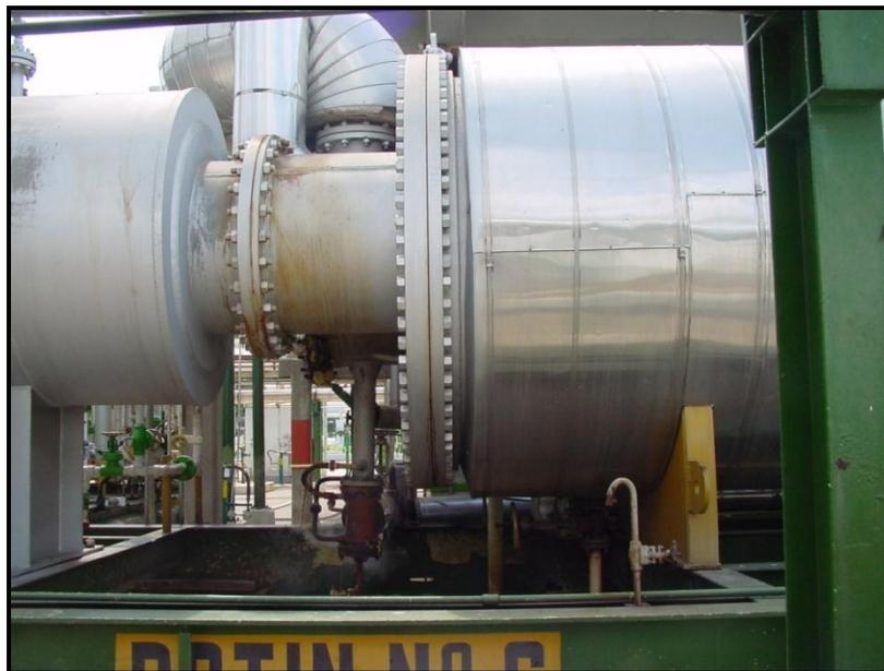
Figura III. 2 Cámara de Combustión H-3A y Recuperador de Calor H-3B existentes.
