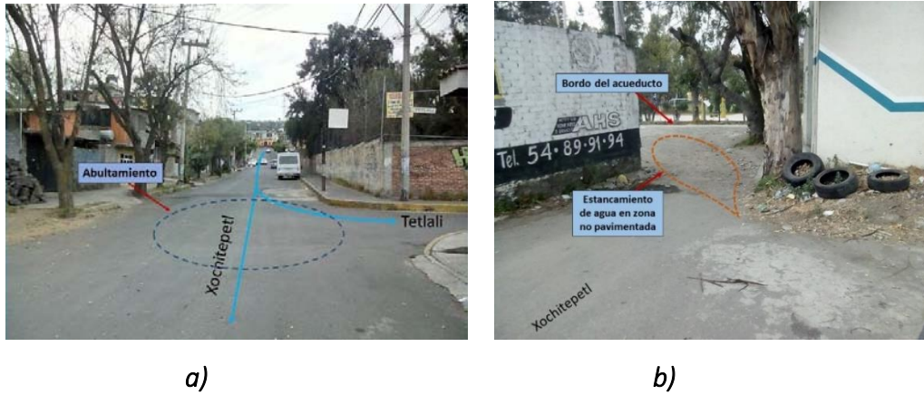
Figura 4.15. Caminamiento; a) Calle en donde se presenta un abultamiento suave generando que el flujo de agua que escurre sobre ellas (en azul), cambie un poco su dirección; b) zona no pavimentada en donde se genera un estancamiento de agua.
