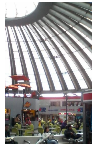
Figura 100-A. Vista del interior del domo.
