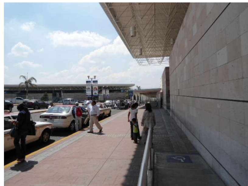
Fig. 9. Vista zona de acceso, Terminal de Morelia, Michoacán.
