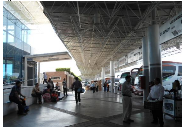
Fig. 95-A. Andenes de la terminal de Morelia, Michoacan.
