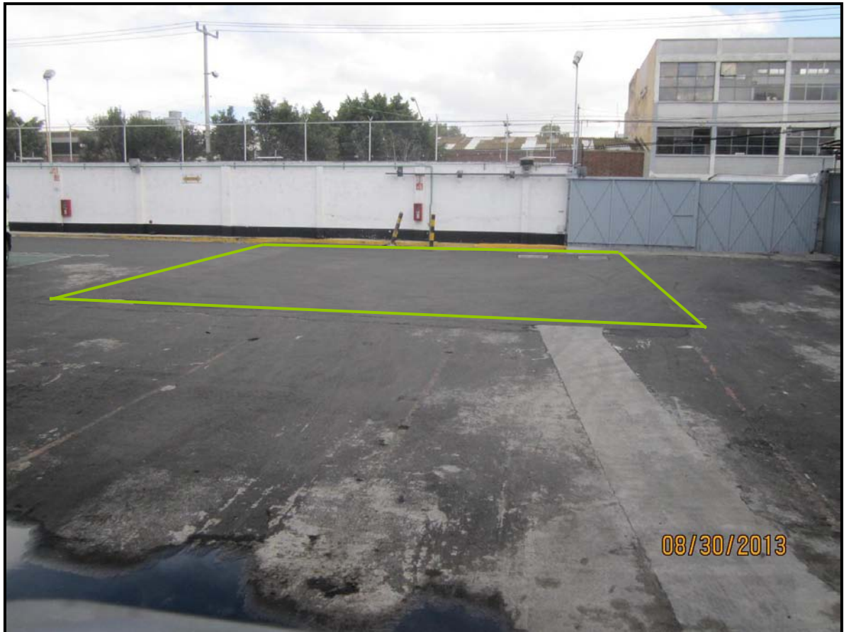
Figura 2.31 Piso sobre el tanque de tormentas enterrado.
