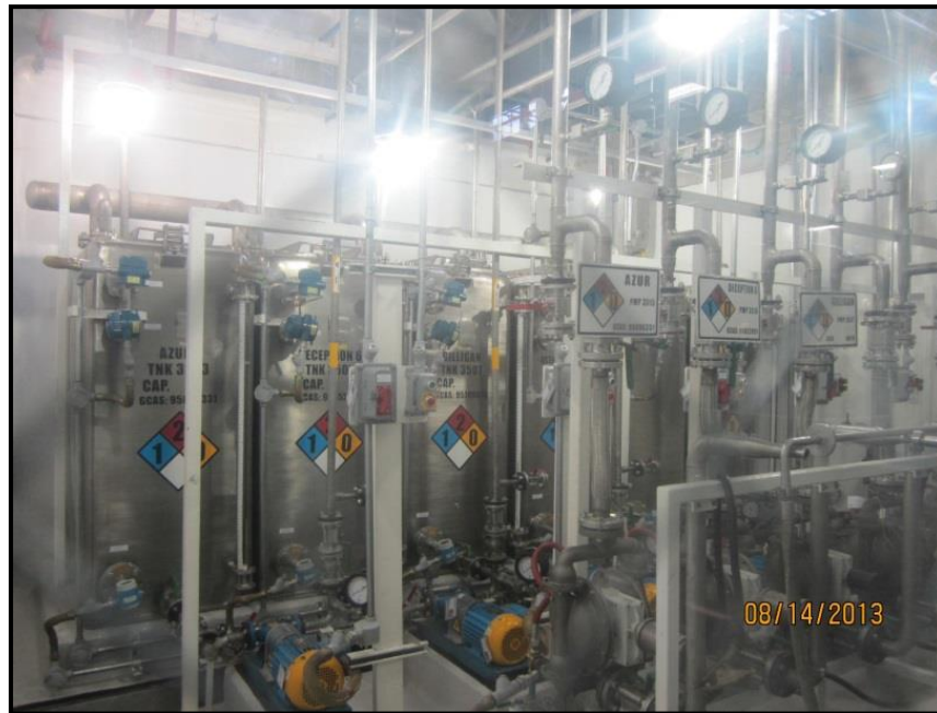
Figura 2.15 Tanques de almacenamiento de perfumes.
