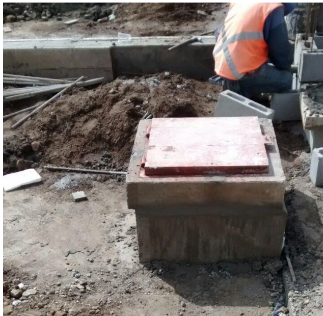
En la Figura 33 y en la figura 34, Pieza3 losa tapa fija. Se aprecia que ya está totalmente enterrada y se podrá inspeccionar a través del paso hombre la caja de infiltración prefabricada Fuente: propia, Referencia: plano 2-B
