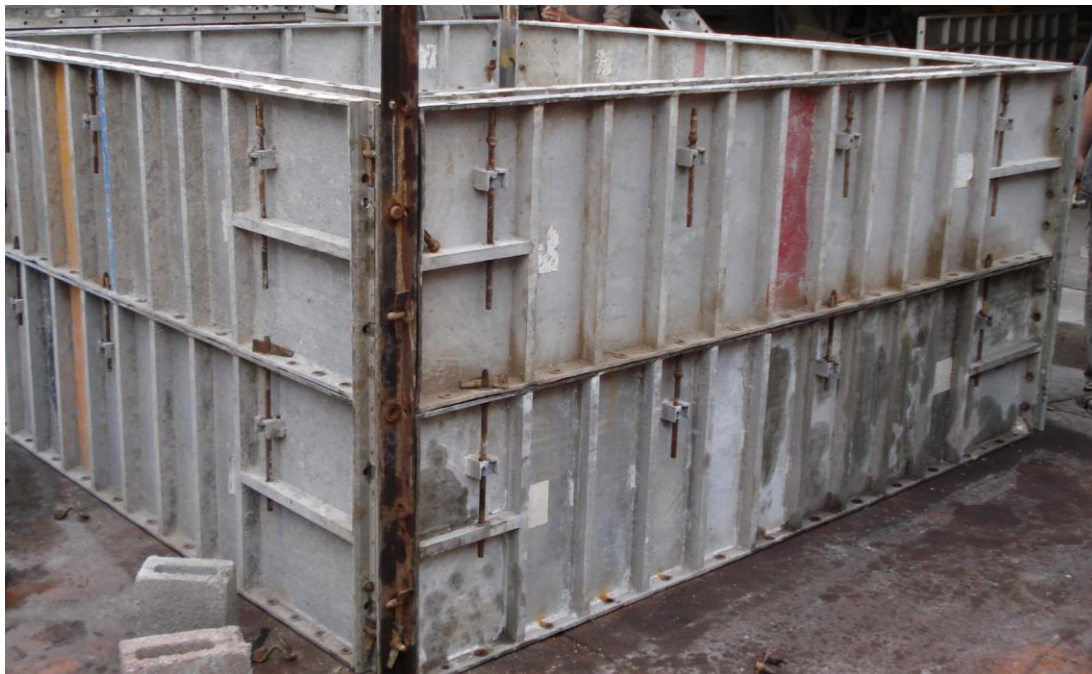
Figura 13, cimbra para pieza 2, anillo de caja de infiltración prefabricada Fuente: propia Referencia: plano 2-A
