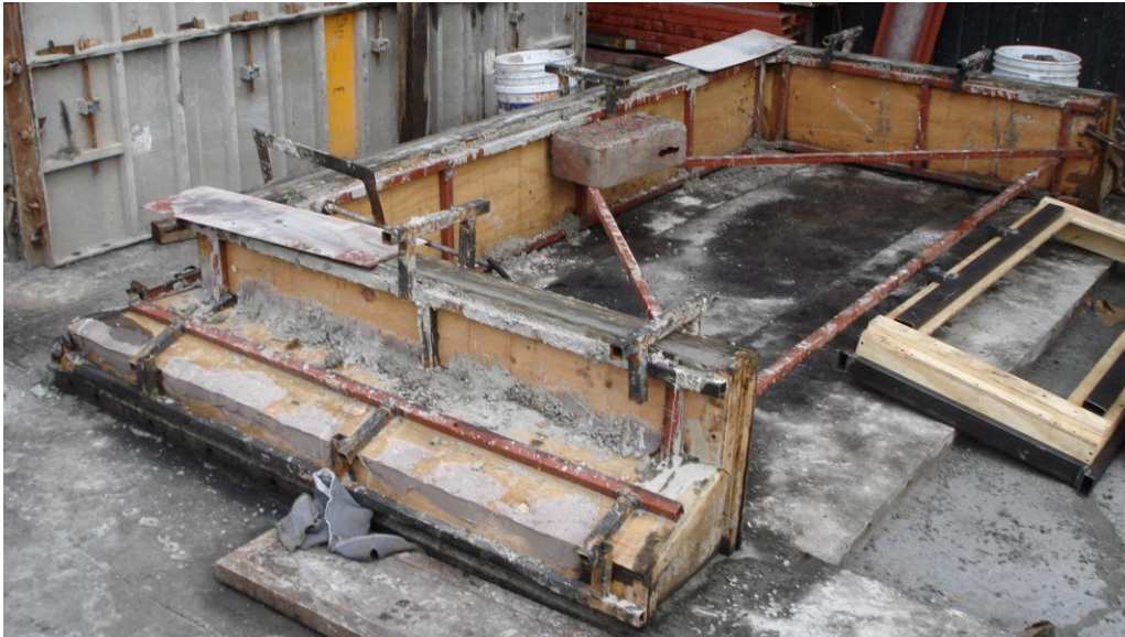
Figura 9. Elemento de Caja de infiltración, prefabricado Pieza1 zapata de caja de infiltración prefabricada Fuente: propia Referencia: plano 2-A
