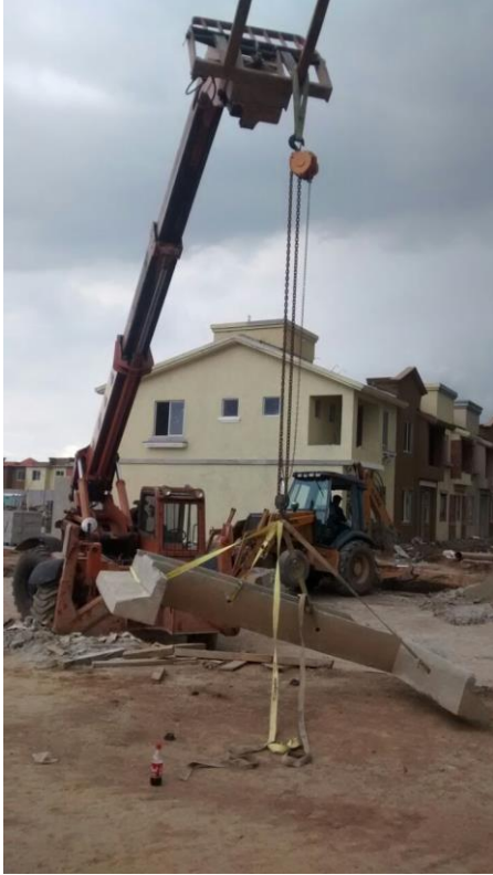
En la Figura 28 y en la figura 29, Pieza1 zapata de cimentación de caja de infiltración prefabricada previamente izada y posteriormente ya en sitio Fuente: propia, Referencia: plano 2-A
