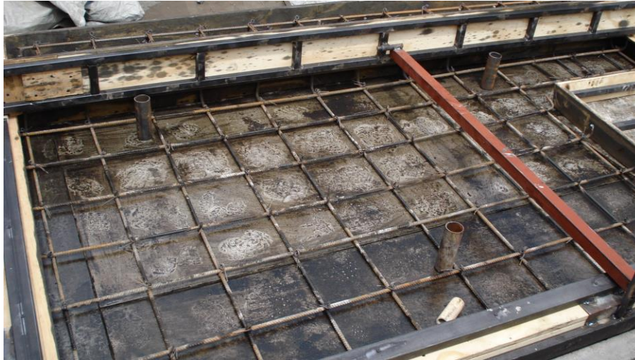
Figura 6, Armado Pieza3 losa tapa de caja de infiltración prefabricada Fuente: propia Referencia: plano E-1
