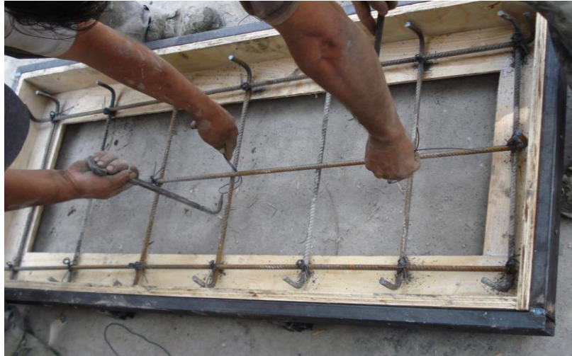
Figura 18, armado de acero y cimbra para un vaciado monolítico de Pieza4 losa tipo (dovelas) de caja de infiltración prefabricada Fuente: propia Referencia: plano E-1
