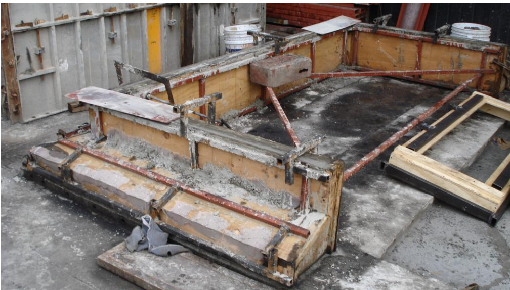
Figura 26, Vaciado de concreto Pieza1 zapata de cimentación de caja de infiltración prefabricada, fabricación Fuente: propia
