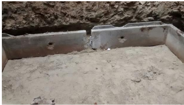
En la Figura 28 y en la figura 29, Pieza1 zapata de cimentación de caja de infiltración prefabricada previamente izada y posteriormente ya en sitio Fuente: propia, Referencia: plano 2-A
