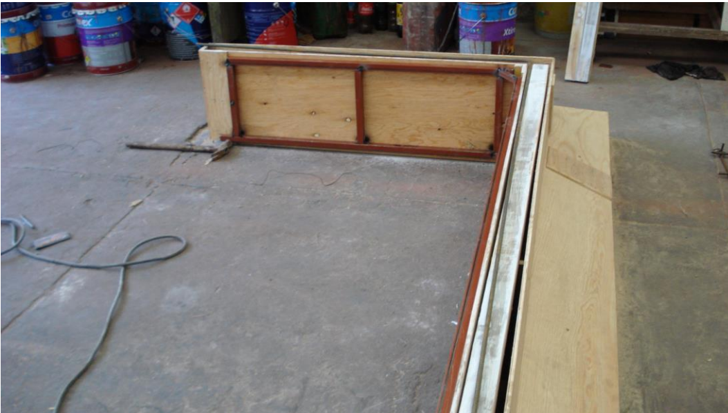
Figura 25, cimbra para un vaciado monolítico de Pieza1 zapata de cimentación, fabricación. Fuente: propia
