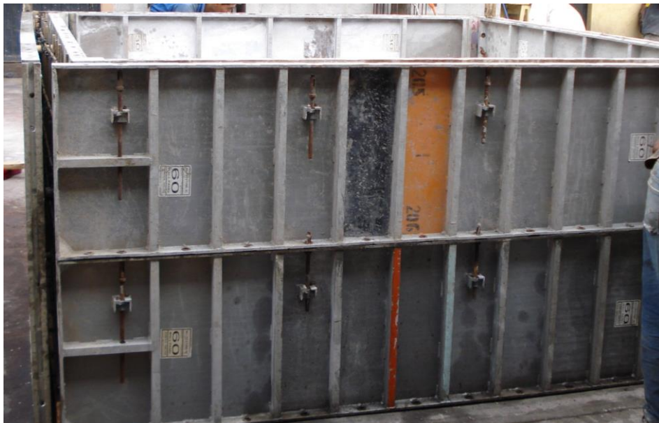
Figura #14, cimbra para pieza #2 anillo de caja de infiltración prefabricada Fuente: propia Referencia: plano 2-A
