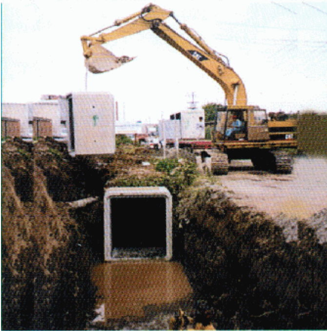
Figura 30, Pieza2 maniobra para bajar prefabricado hacia ensamble de caja de infiltración prefabricada Fuente: propia Referencia: plano 2-A
