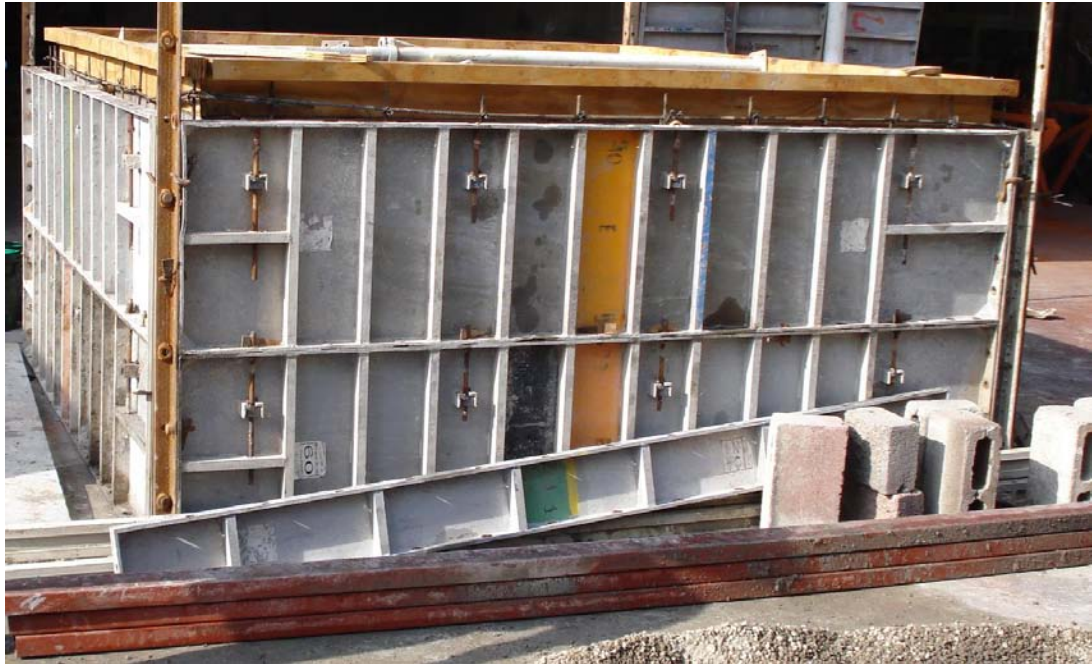
Figura 12, cimbra para pieza 2, anillo de caja de infiltración prefabricada Fuente: propia Referencia: plano 2-A
