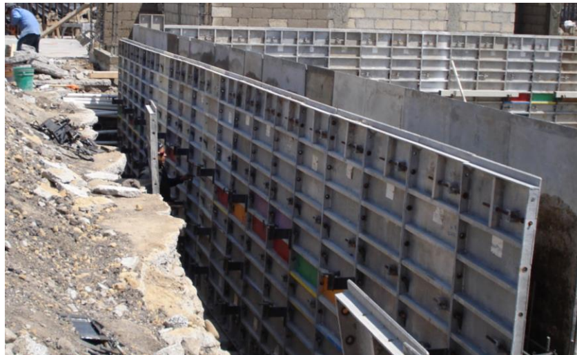
Figura 5, cimbra para vaciar en sitio de Caja de infiltración, Fuente: propia
