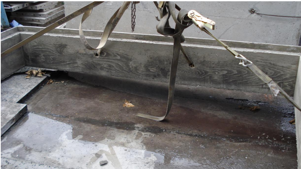
Figura 35, Elemento de Caja de infiltración, (Pieza#1 zapata de cimentación de caja de infiltración prefabricada) Fuente: propia Referencia: plano 2-A
