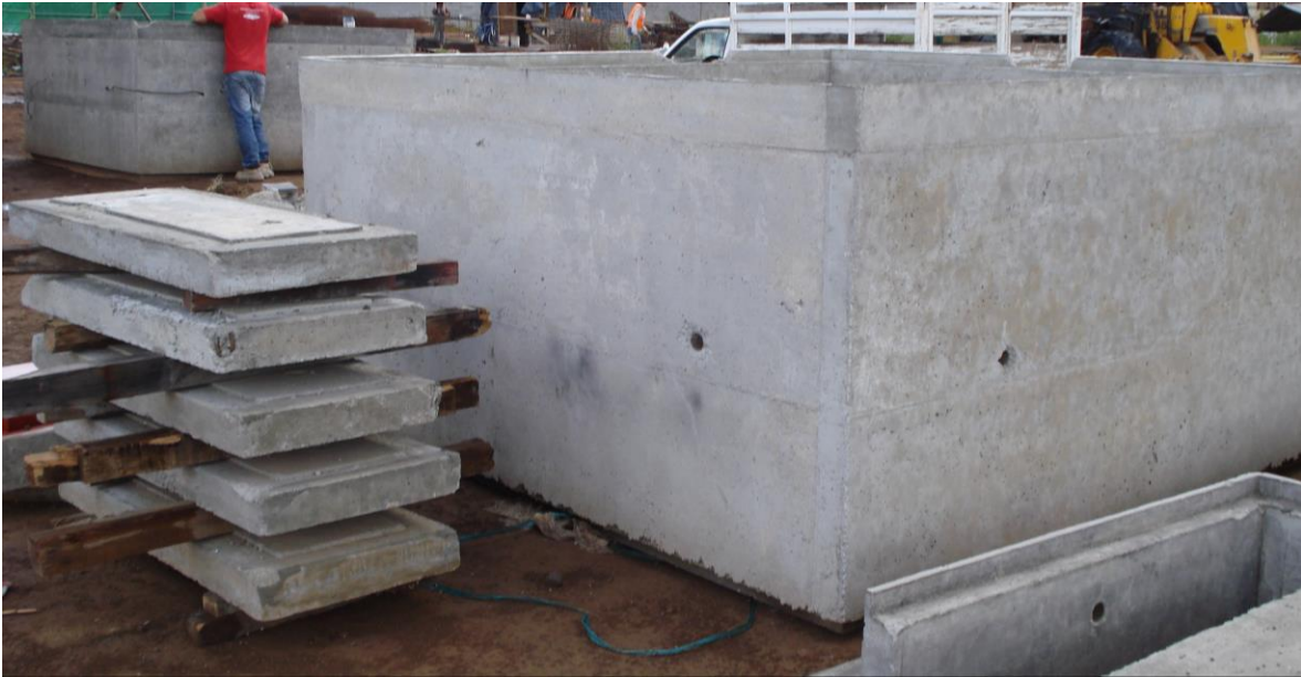
Figura 23, entrega de piezas prefabricadas en sitio de obra para su instalación. Fuente: propia
