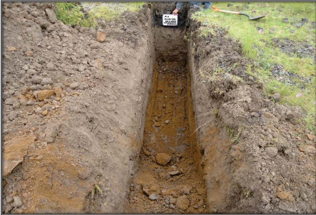
Sitio excavado para el PCA en el KM 120+820
