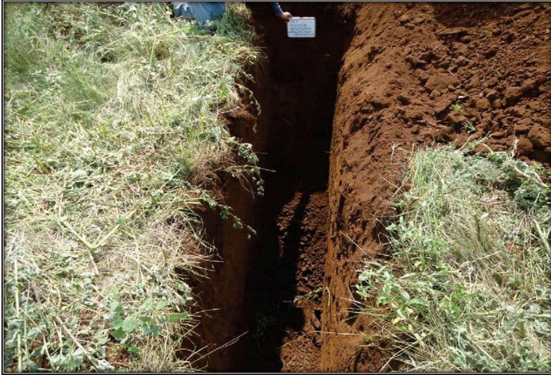
Sitio excavado para el PCA en el KM 110+500
