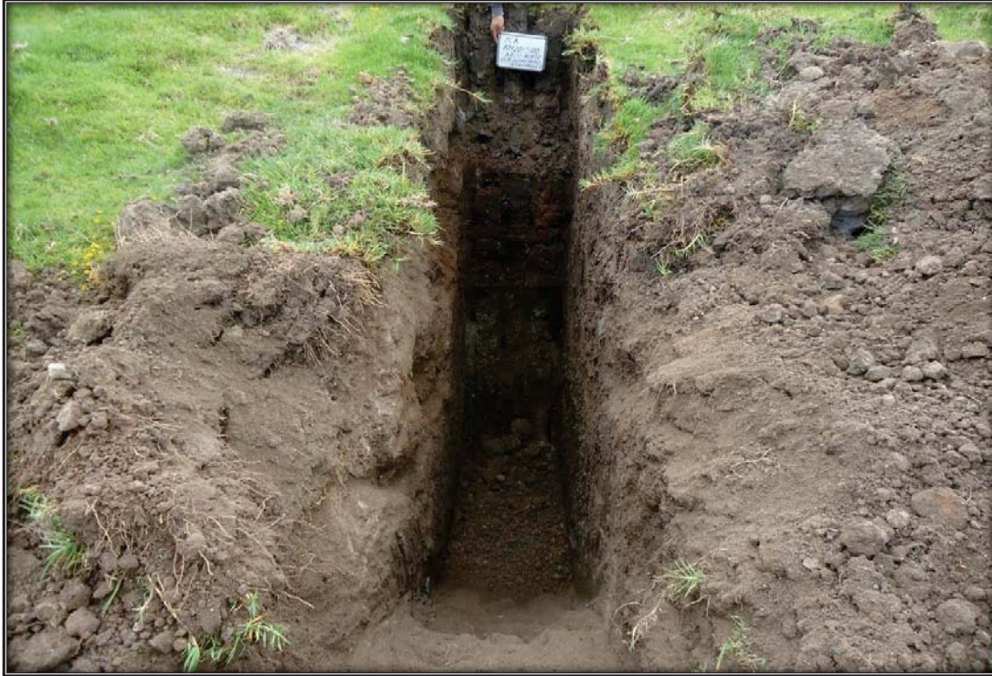
Sitio excavado para el PCA en el KM 122+700
