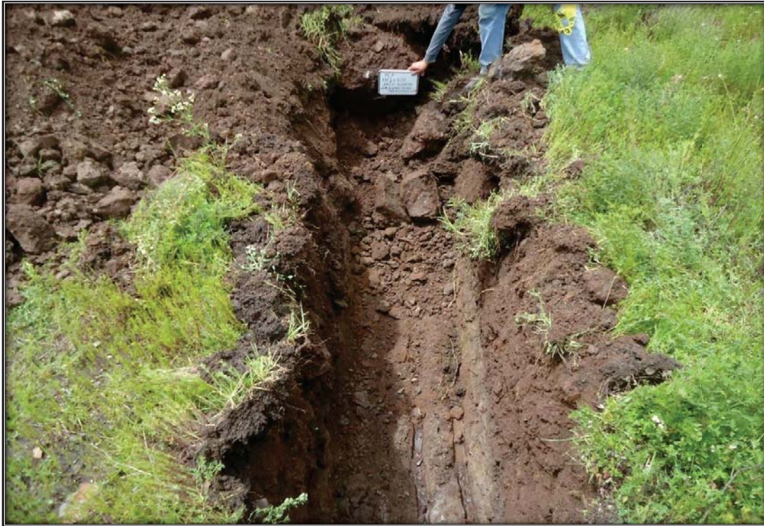
Sitio excavado para el PCA en el KM 108+320
