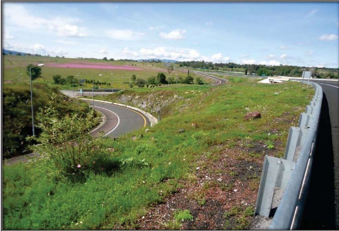
Sitio excavado para el PCA en el KM 106+070, se observa roca y parte de cuerpo existente
