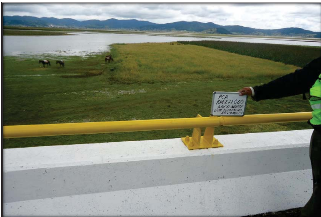
Sitio excavado para el PCA en el KM 129+320 Área de inundación
