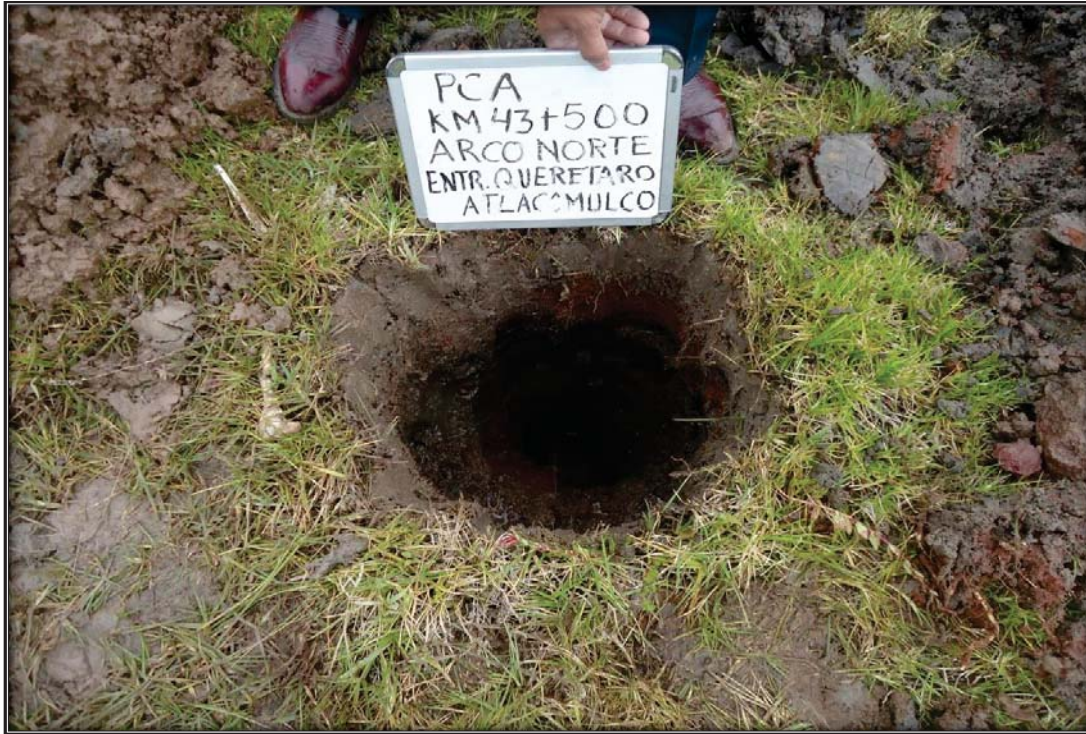
Sitio excavado para el PCA en el KM 146+000
