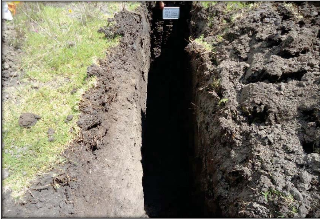
Sitio excavado para el PCA en el KM 118+720
