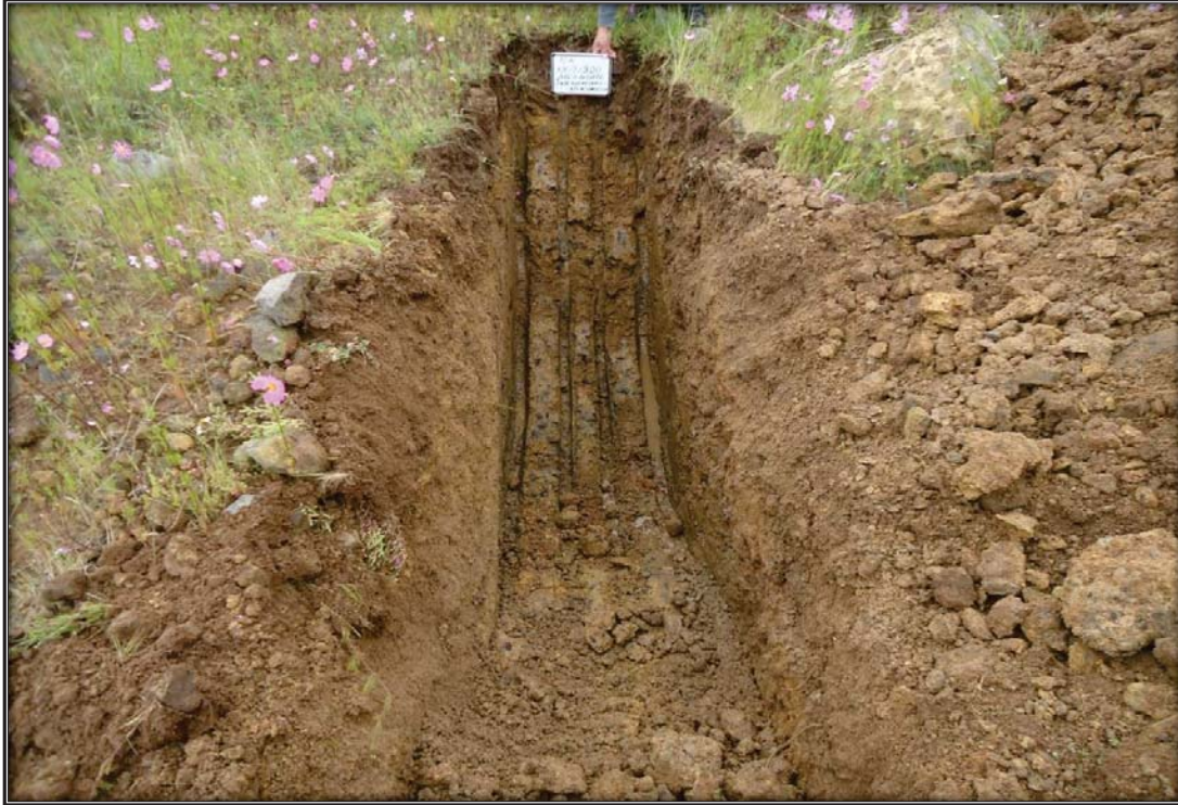
Sitio excavado para el PCA en el KM 114+560
