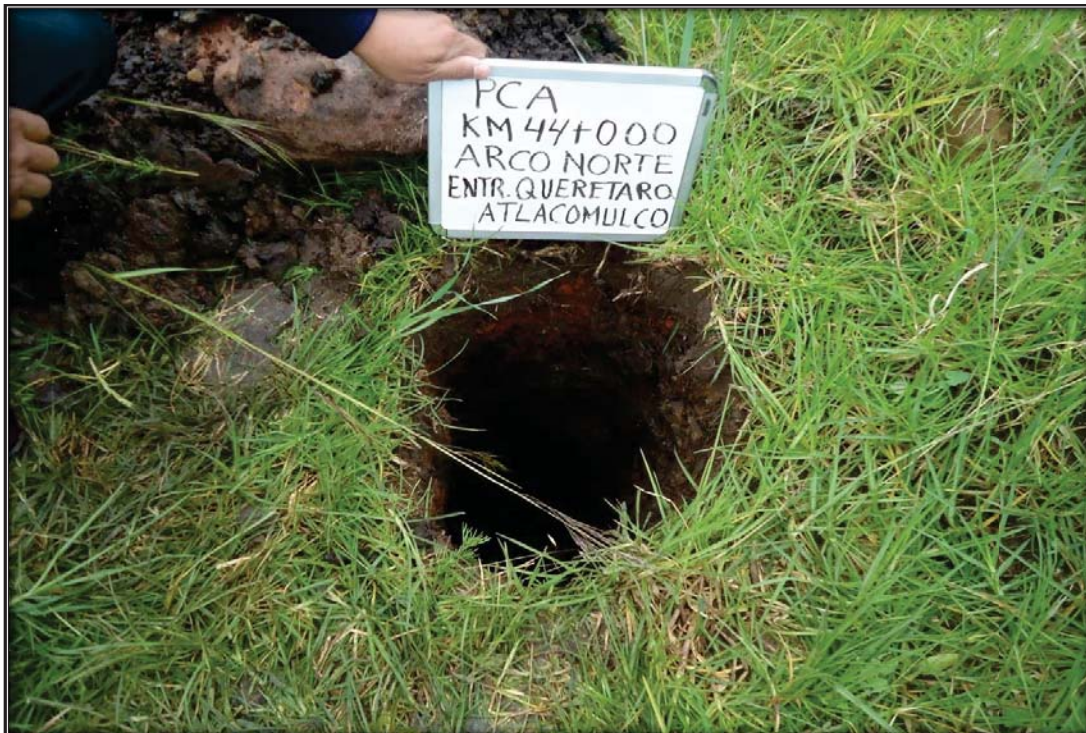
Sitio excavado para el PCA en el KM 146+500
