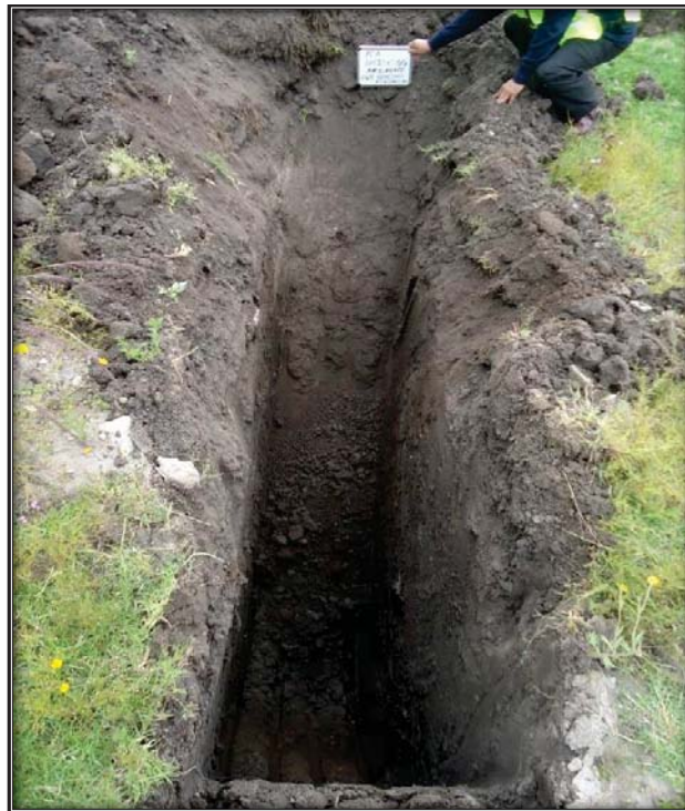
Sitio excavado para el PCA en el KM 135+780
