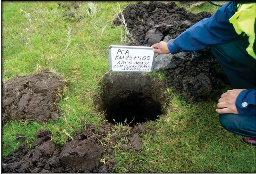
Sitio excavado para el PCA en el KM 127+860
