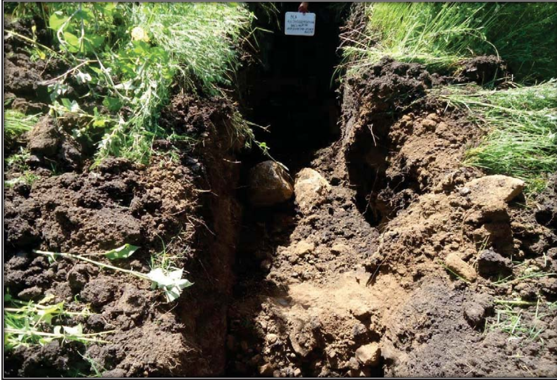
Sitio excavado para el PCA en el KM 105+070
