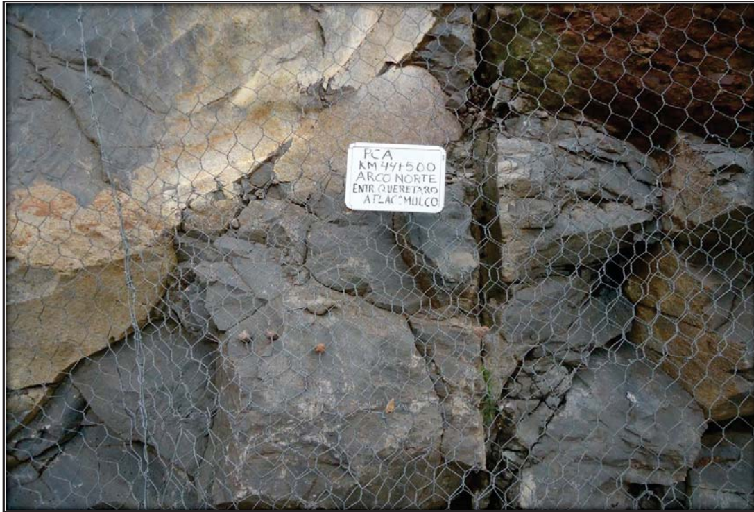
Sitio excavado para el PCA en el KM 147+000 Área de roca
