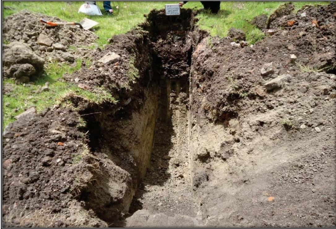
Sitio excavado para el PCA en el KM 135+120
