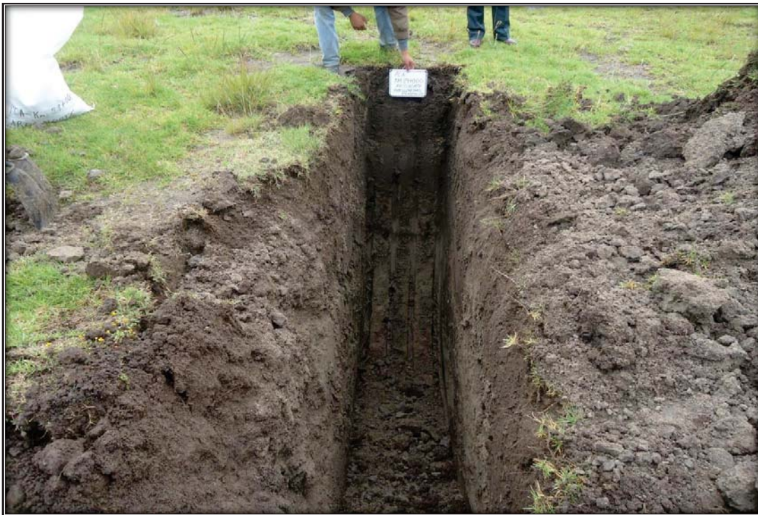
Sitio excavado para el PCA en el KM 131+500
