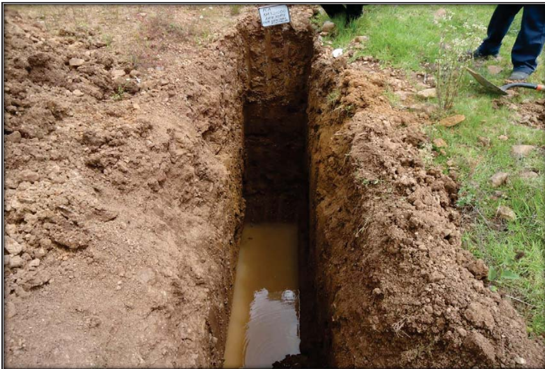
Sitio excavado para el PCA en el KM 134+540
