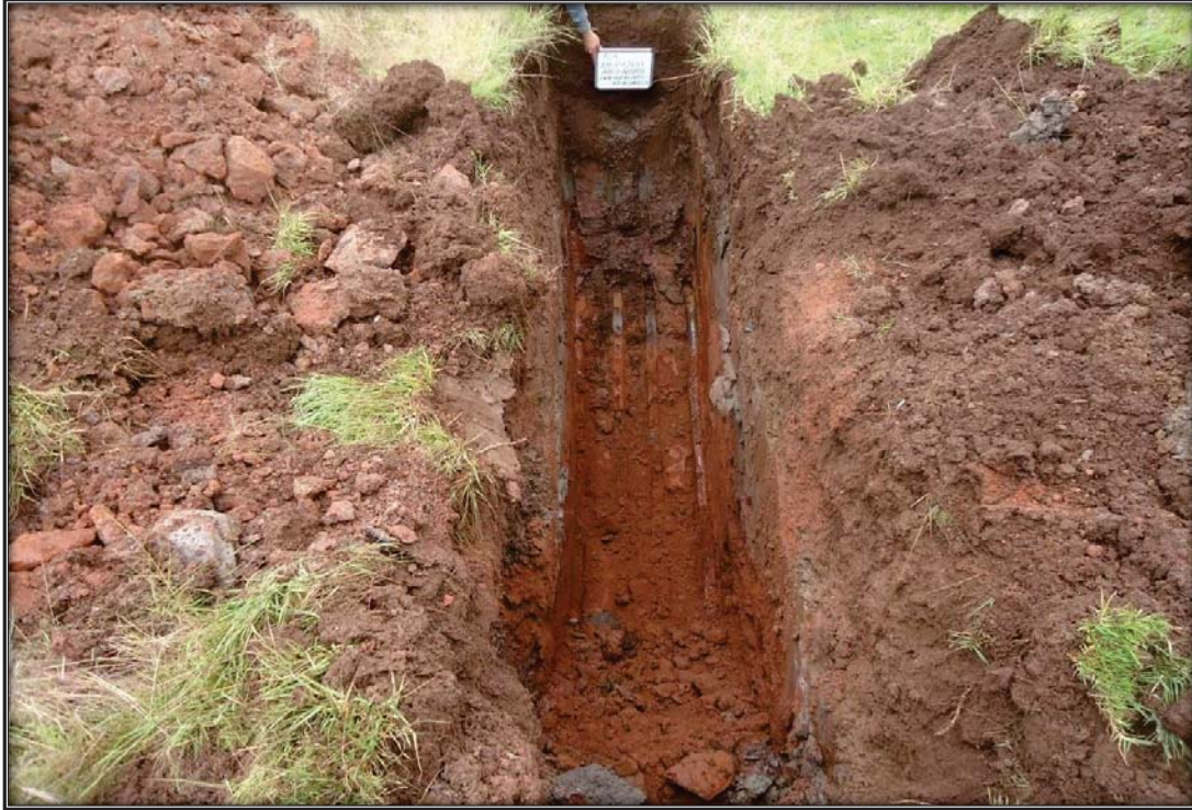
Sitio excavado para el PCA en el KM 112+540
