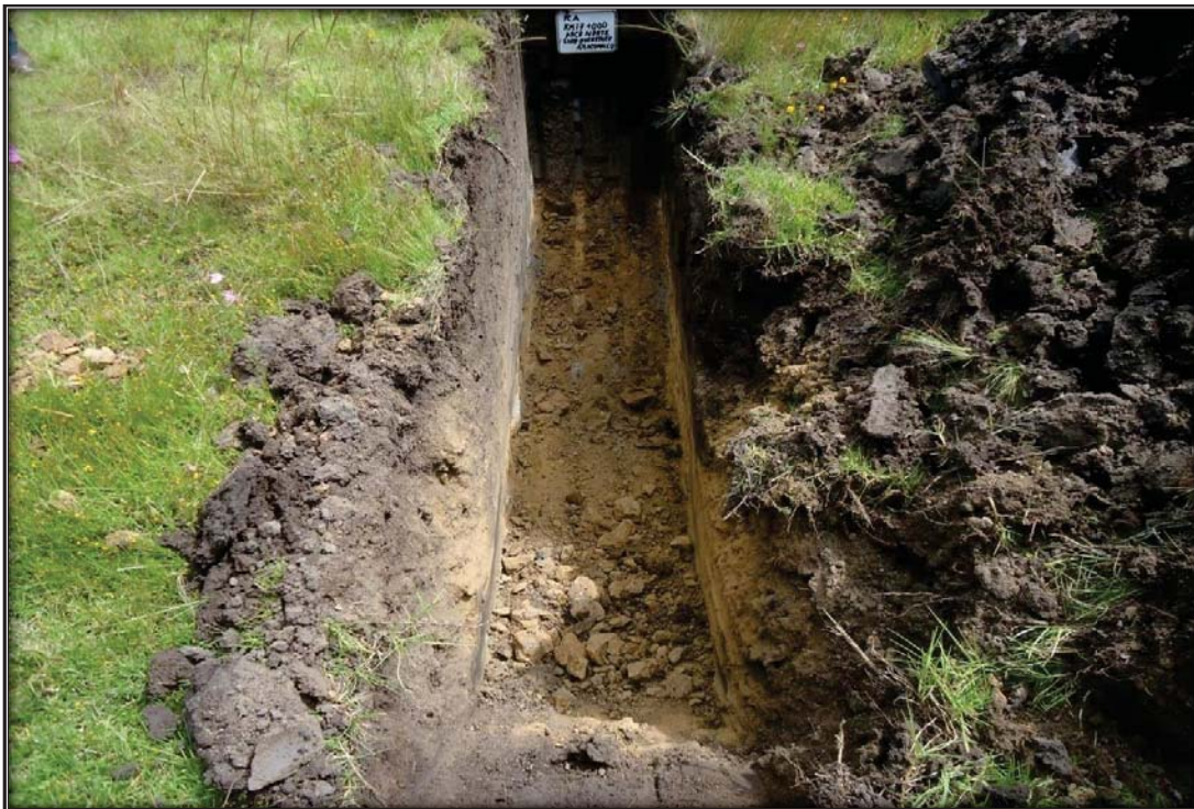
Sitio excavado para el PCA en el KM 119+200
