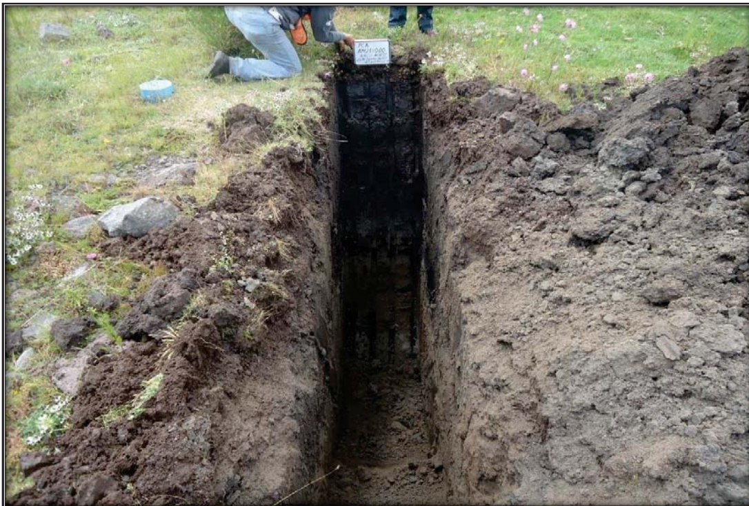
Sitio excavado para el PCA en el KM 123+360
