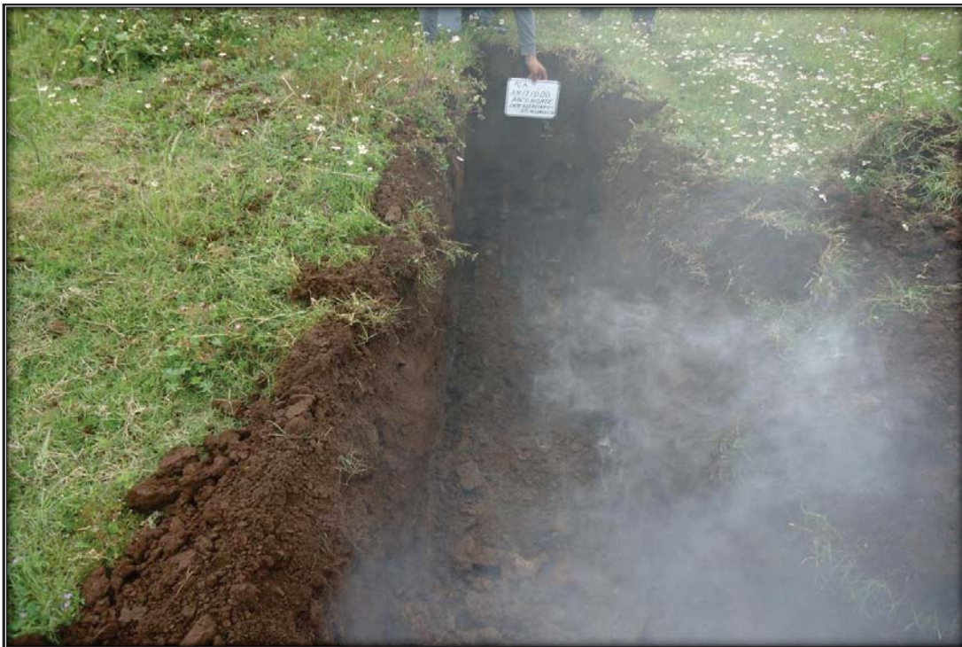
Sitio excavado para el PCA en el KM 114+040
