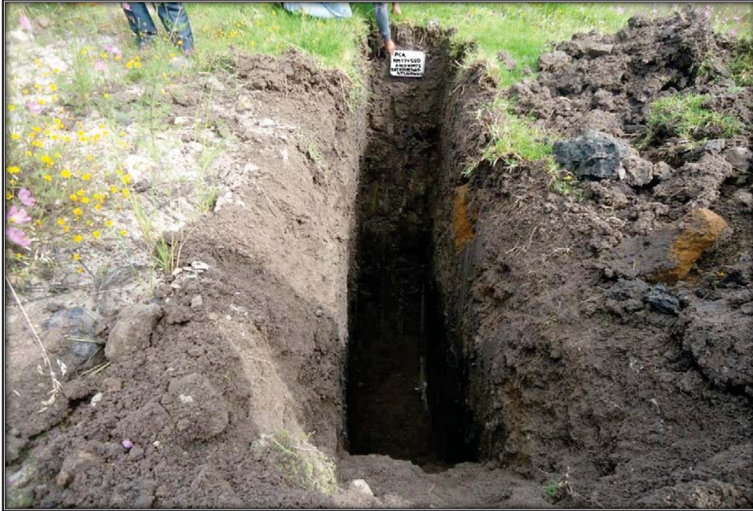
Sitio excavado para el PCA en el KM 119+800
