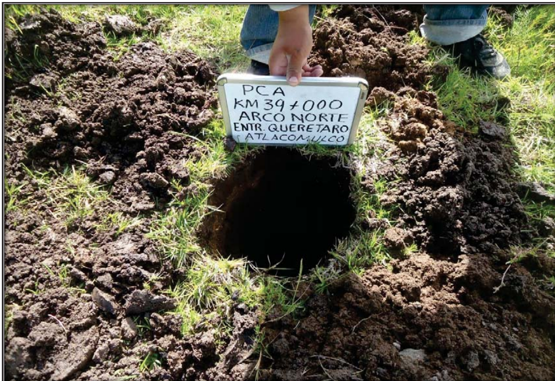
Sitio excavado para el PCA en el KM 141+500
