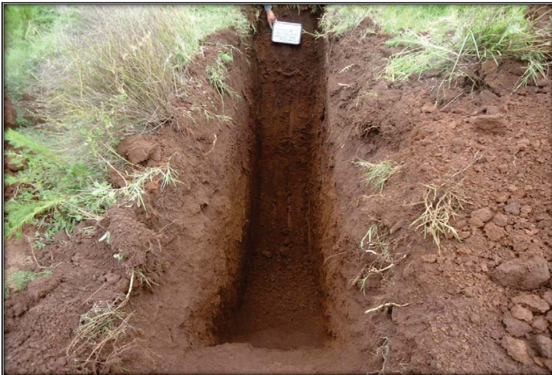
Sitio excavado para el PCA en el KM 112+000
