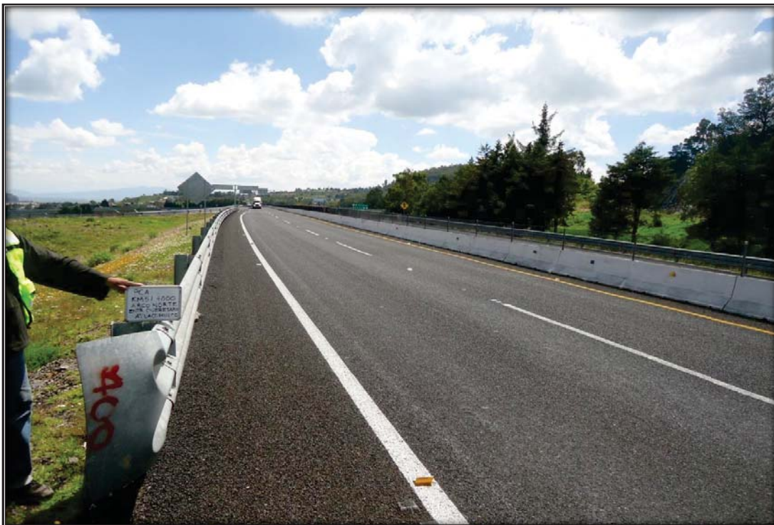
Sitio excavado para el PCA en el KM 153+500 Área del entronque Atlacomulco
