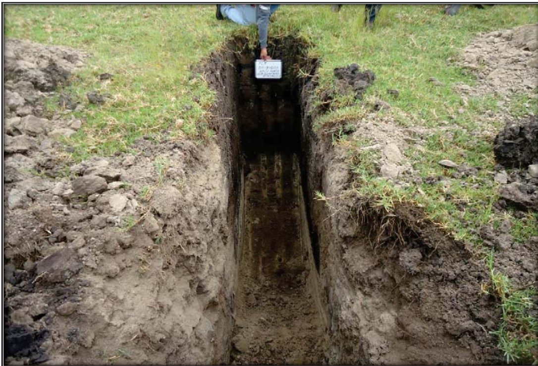
Sitio excavado para el PCA en el KM 121+140
