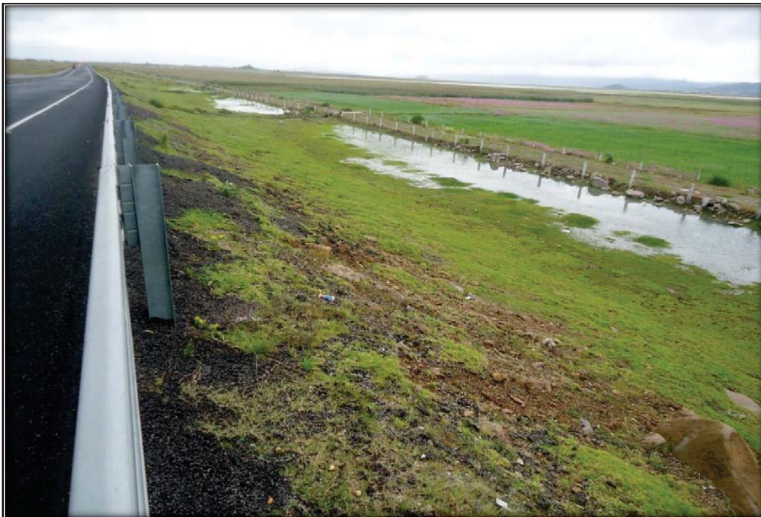
Sitio excavado para el PCA en el KM 132+500 Área de inundación
