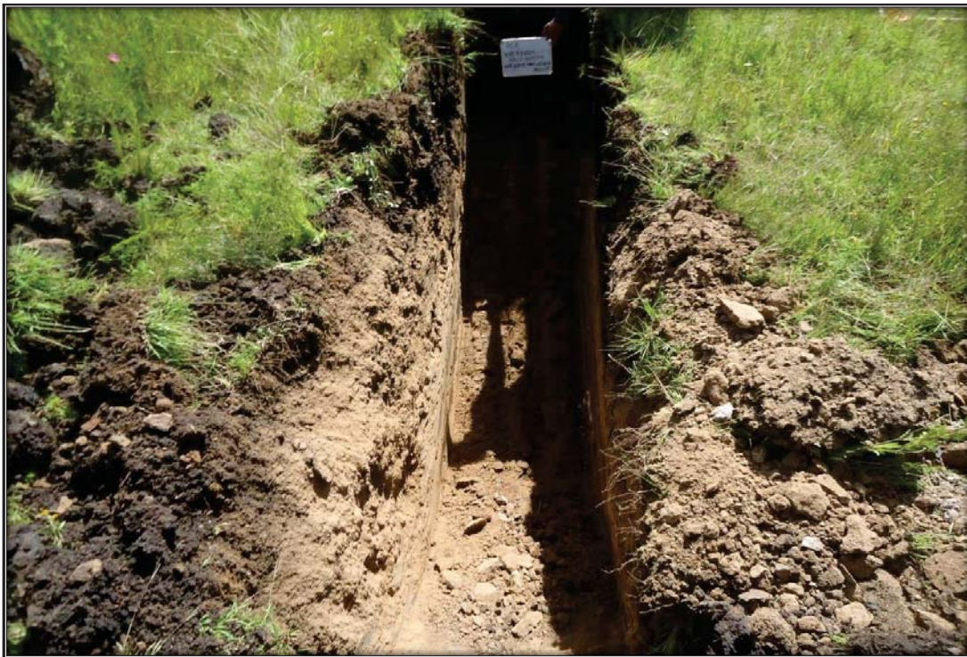
Sitio excavado para el PCA en el KM 105+560
