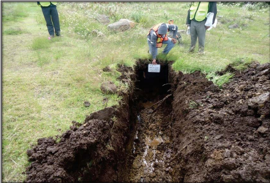
Sitio excavado para el PCA en el KM 122+280
