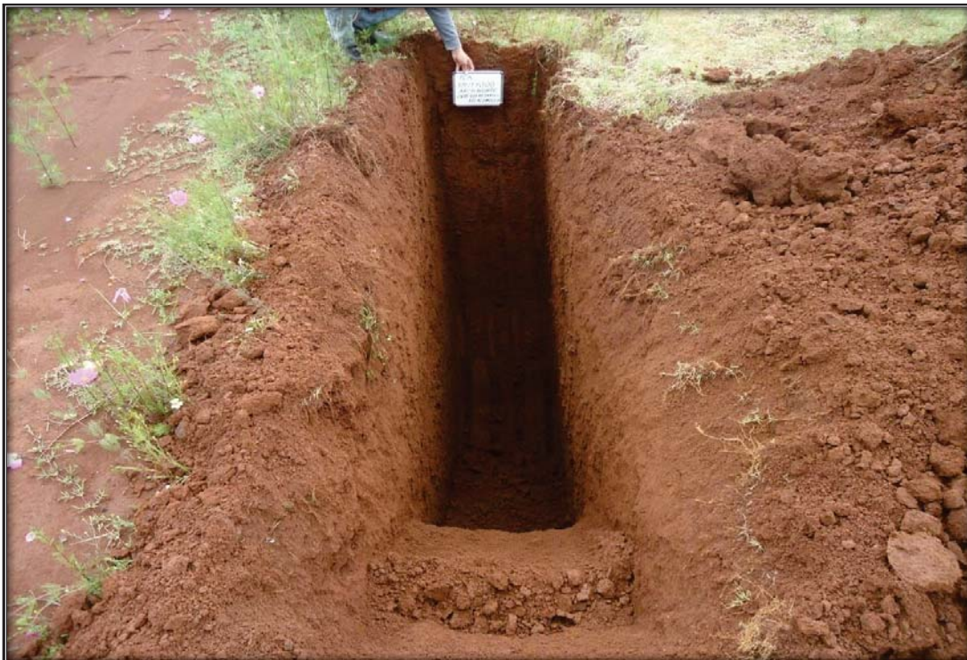
Sitio excavado para el PCA en el KM 113+020
