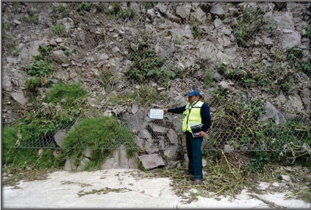
Sitio excavado para el PCA en el KM 140+000 Área de roca
