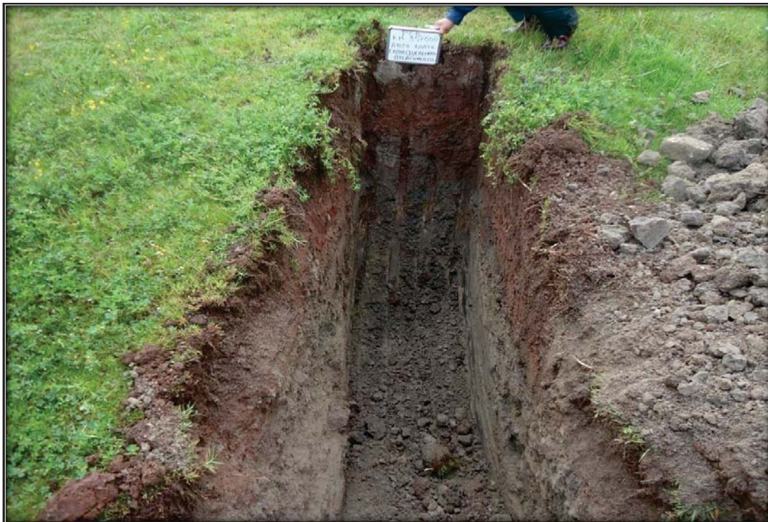
Sitio excavado para el PCA en el KM 137+480
