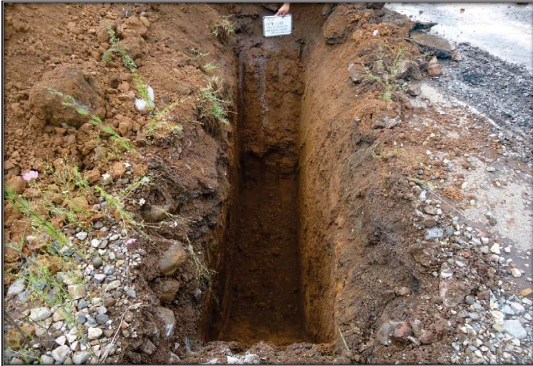
Sitio excavado para el PCA en el KM 111+520
