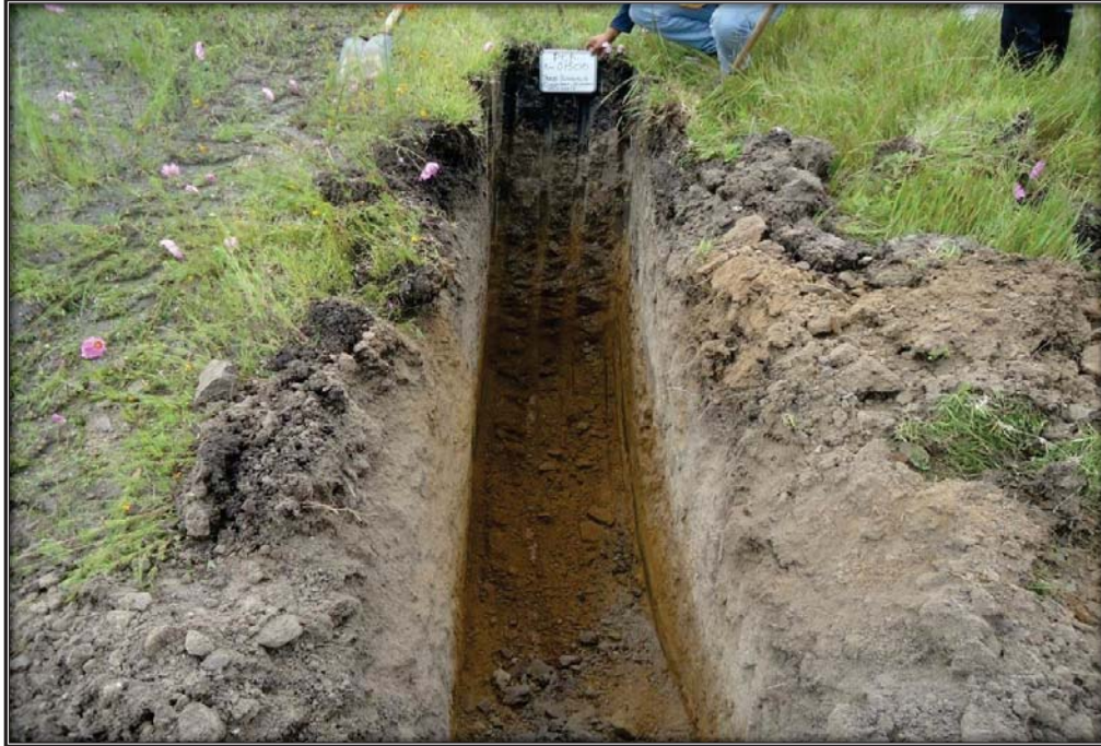
Sitio excavado para el PCA en el KM 101+900
