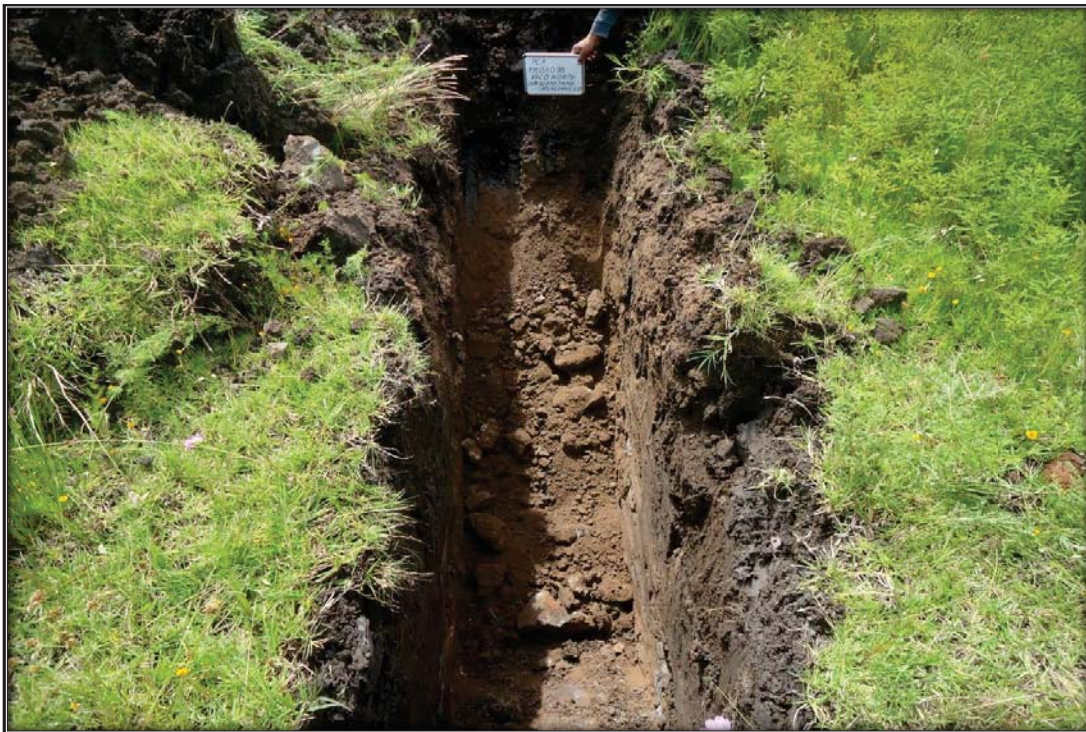
Sitio excavado para el PCA en el KM 109+980
