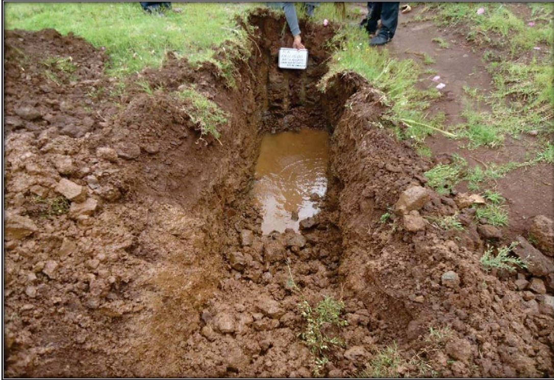
Sitio excavado para el PCA en el KM 113+520
