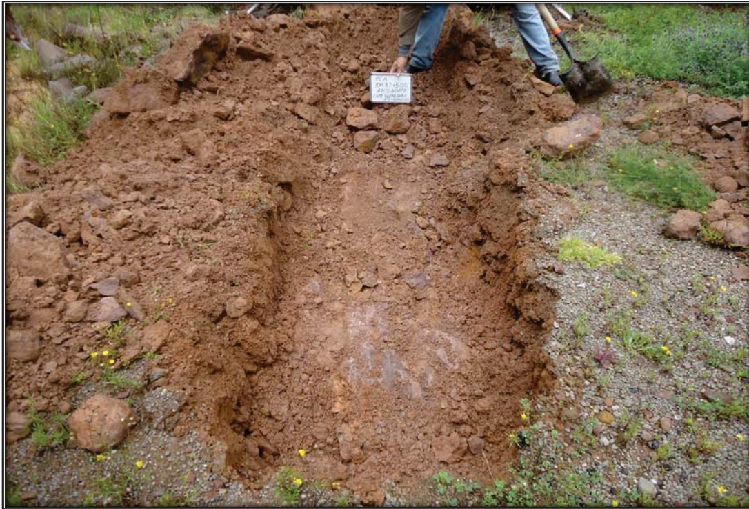
Sitio excavado para el PCA en el KM 134+060 Área de roca
