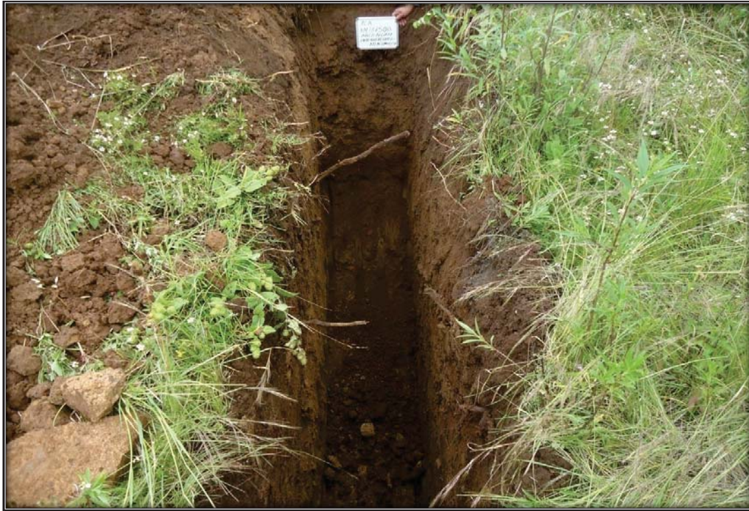
Sitio excavado para el PCA en el KM 115+500
