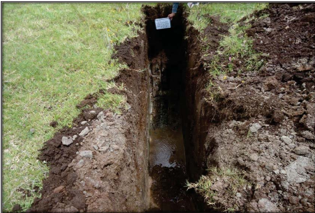
Sitio excavado para el PCA en el KM 117+160
