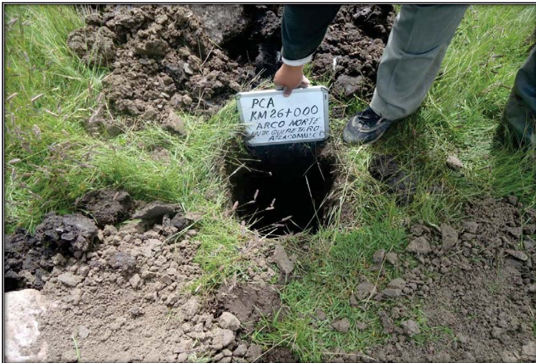
Sitio excavado para el PCA en el KM 128+420
