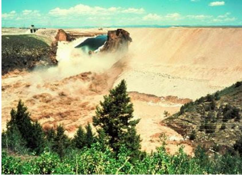
Figura 9: Brecha Presa Teton.
