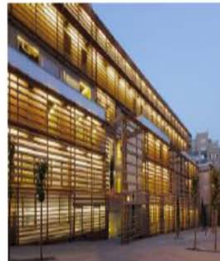
Tipos de protecciones en ventanas para evitar deslumbramientos según la orientación de las mismas
