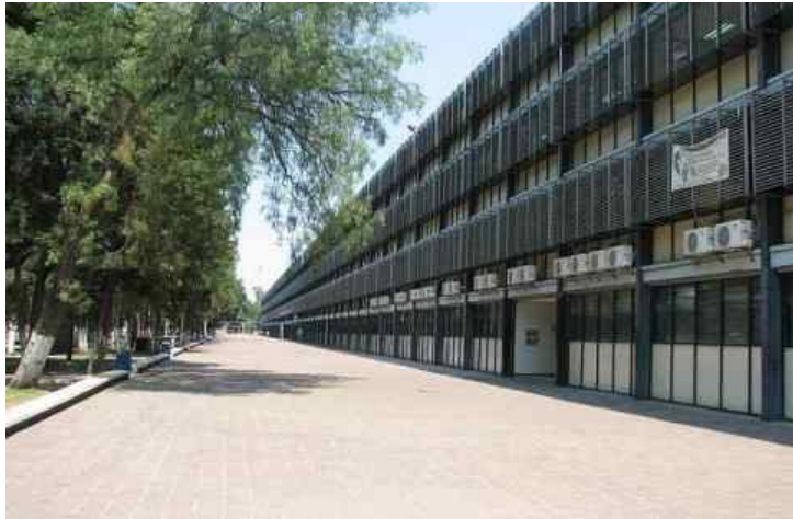
EDIFICIO DE INGENIERÍA PETROLÉRA, UNIDAD ZACATENCO, IPN
