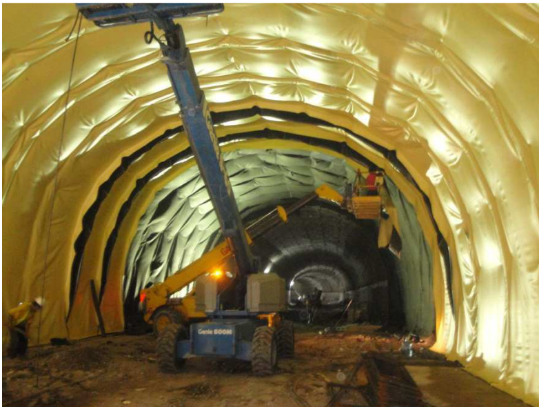
Fig. 5.1.1 impermeabilización de las paredes de túnel, al fondo se observa la colocación del geotextil de color negro, y de color amarillo la geomembrana
