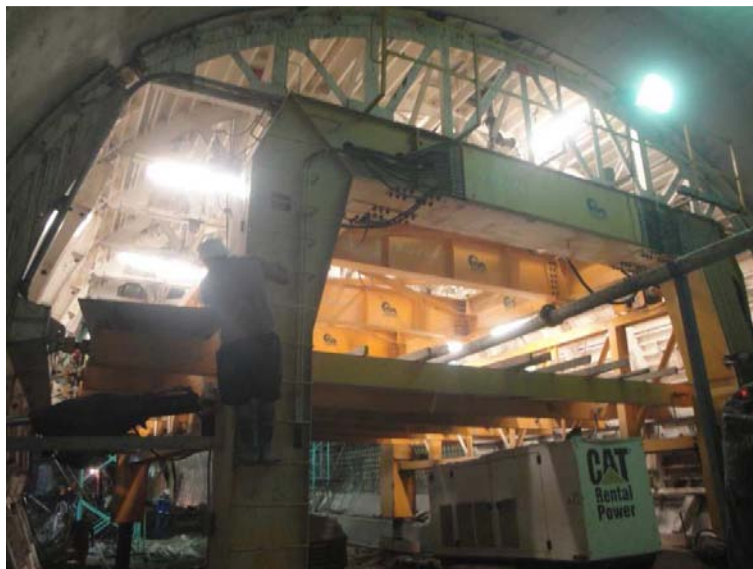
Fig. 5.2.1 Cimbra deslizante utilizada para el revestimiento definitivo
