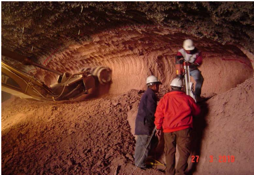
fig. 4.1.6 máquina retroexcavadora trabajando con rozadora, trazo de rojo realizado previamente por topografía
