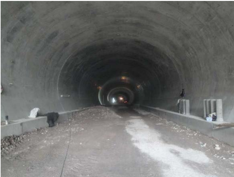
Fig. 5.1.3 revestimiento definitivo de túnel
