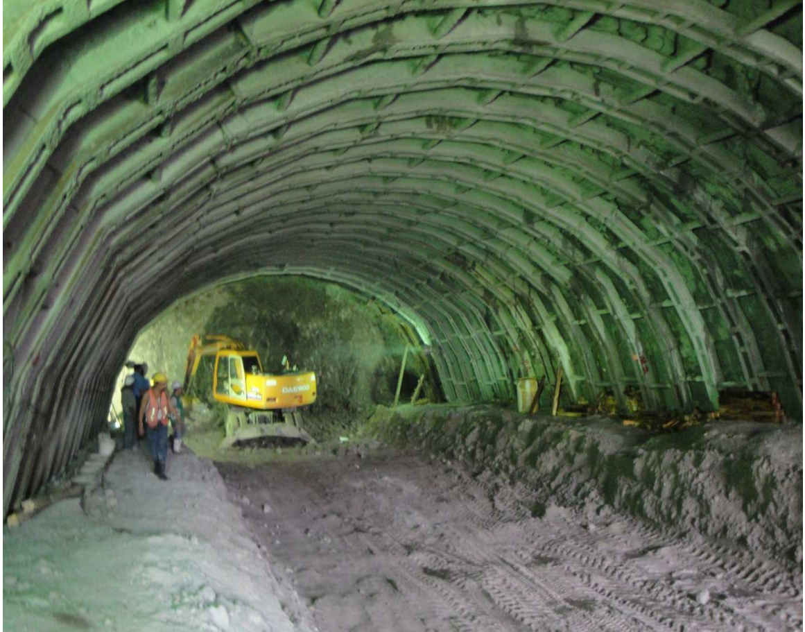
Fig. 2.3.5 túnel con sostenimiento, por medio de marcos metálico
