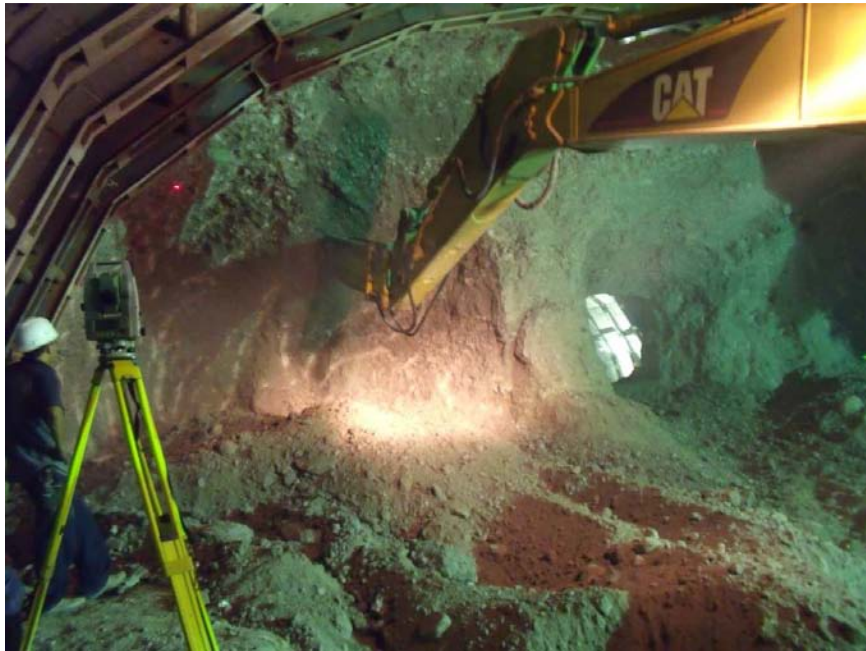
Fig. 4.1.4 Estación total a un lado del eje, indicando el límite de corte, con el rayo láser previo a una comunicación
