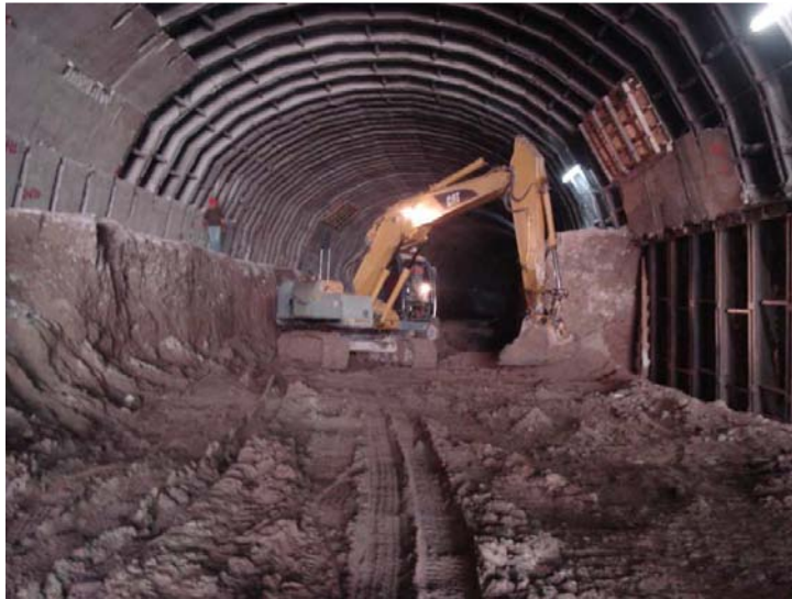
Fig. 4.3.2 excavación del banqueo central y lateral para colocar el complemento del marco
