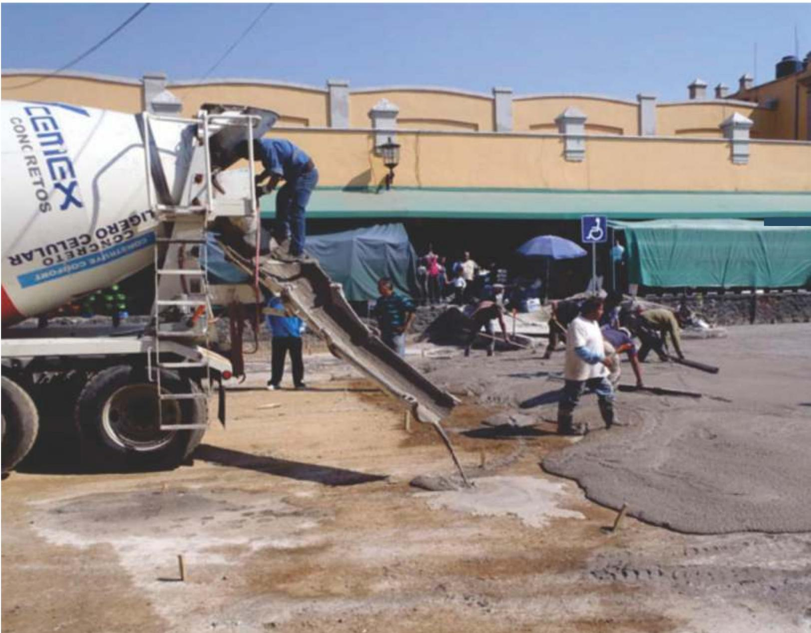
Aplicación de la primera capa de cemento para la pavimentación
