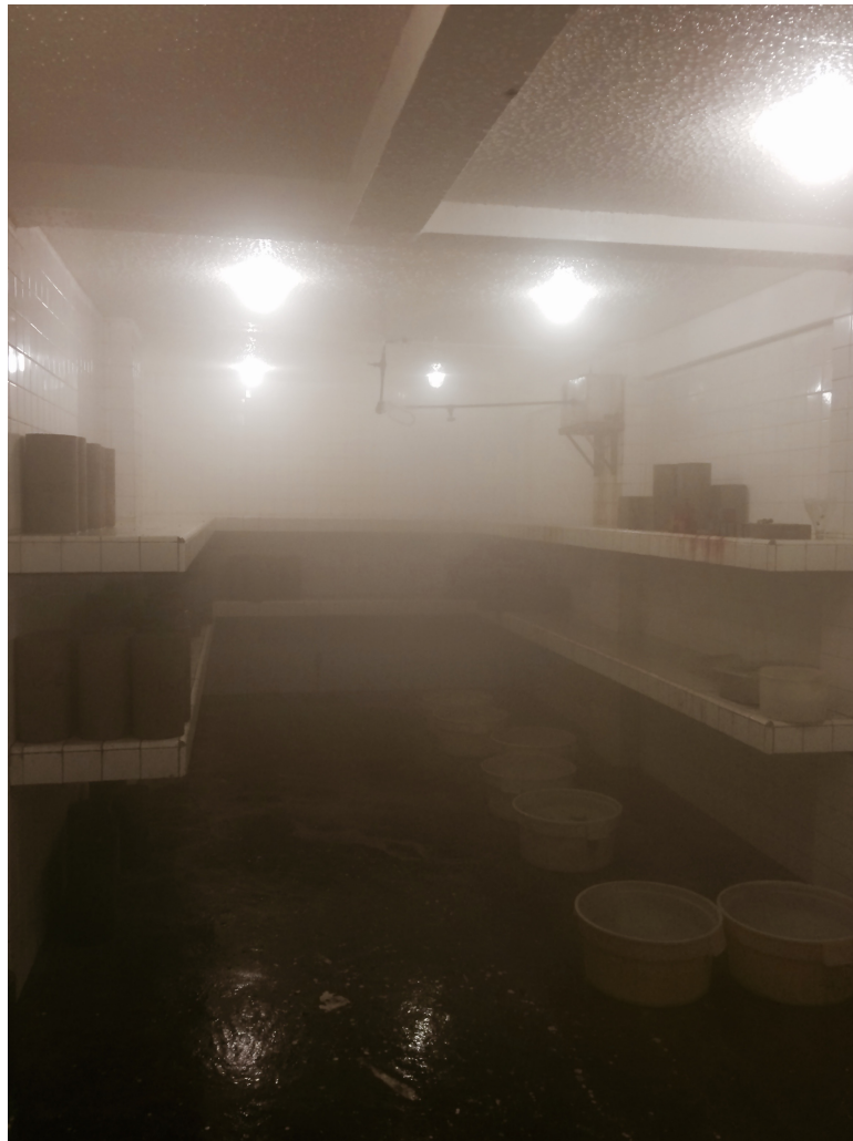
Figura 3.4: Cuarto de curado, Instituto de Ingeniería UNAM
