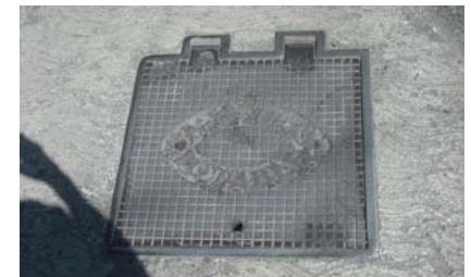
Agua potable sobre la calle Coporo orientación suroeste
