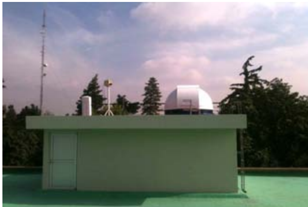
Figura 8. Vista actual del observatorio en la azotea del CCA-UNAM equipado con el espectrómetro VERTEX 80 y el domo con el rastreador solar. El observatorio atmosférico de la UNAM también aloja otros equipos de percepción remota como un LIDAR y un MAX-DOAS.
