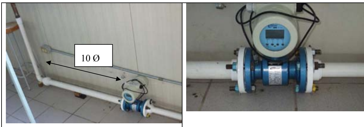
Figura 6.3 Medidor de Caudal Electromagnético.
