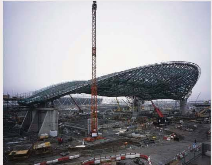
Apoyos de Concreto armado.
