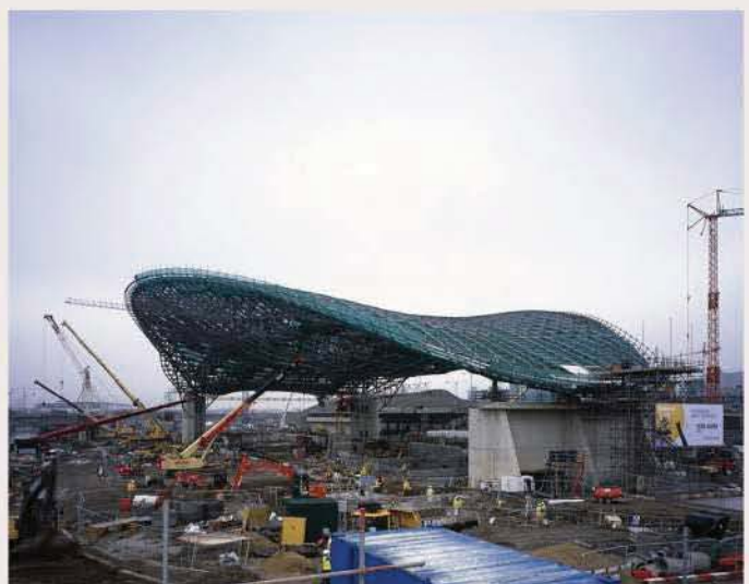
Estructura Metálica, Centro Acuático.
