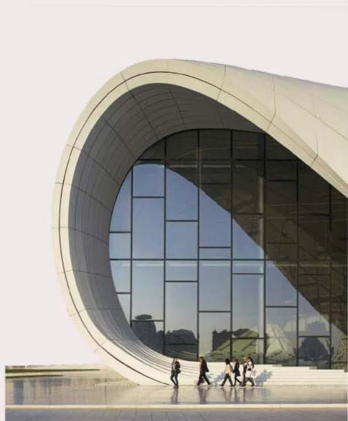
Detalle de Fachada.
