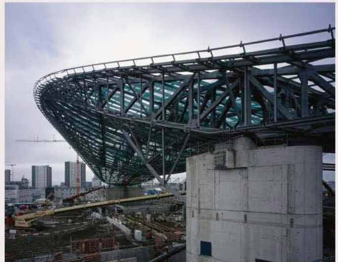
Estructura Metálica, Centro Acuático.
