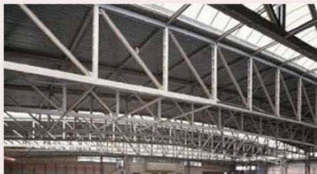
Ejemplo sistema de armaduras.
