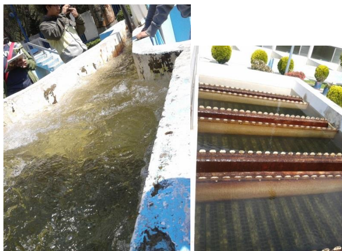
Figuras 3.77-3.78 En la imagen del lado izquierdo se muestra el canal Parshall que tiene por objetivo generar turbulencia en el agua con el propósito de dispersar sustancias químicas.
