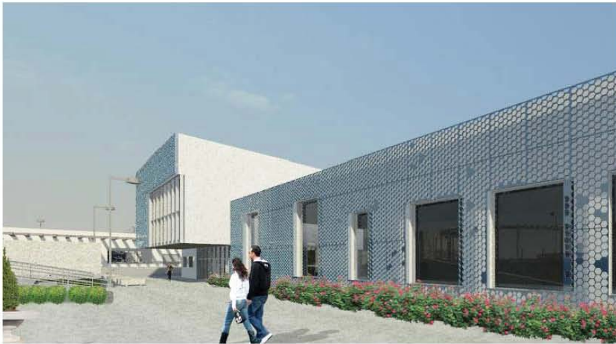
Biblioteca. Vista general 2
