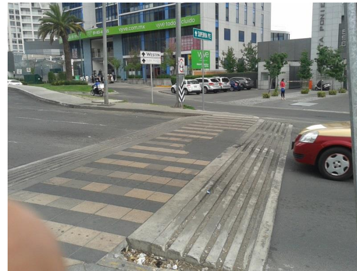
Imagen 75: Paso peatonal con rampa de desaceleración.
