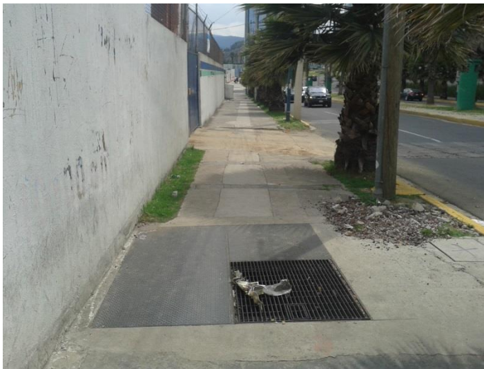
Imagen 74: Banqueta Av. Santa Fe
