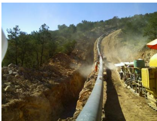
Figura 1. Construcción de línea regular
