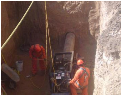
Figura 9. Cruce tuneleado INAH
