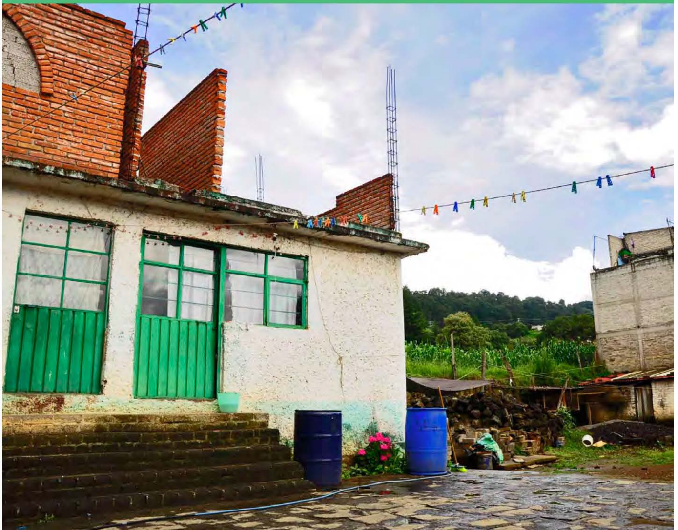
Fotografía: Vivienda Trinidad Aguilar no.2 Nombre: "Vista desde el patio"
