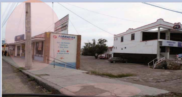
Elementos dañados en Infraestructura.
