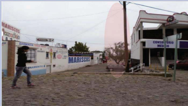
Deterioro de postes eléctricos y Telefonía.
