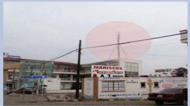
Cableado que genera mal aspecto Visual
