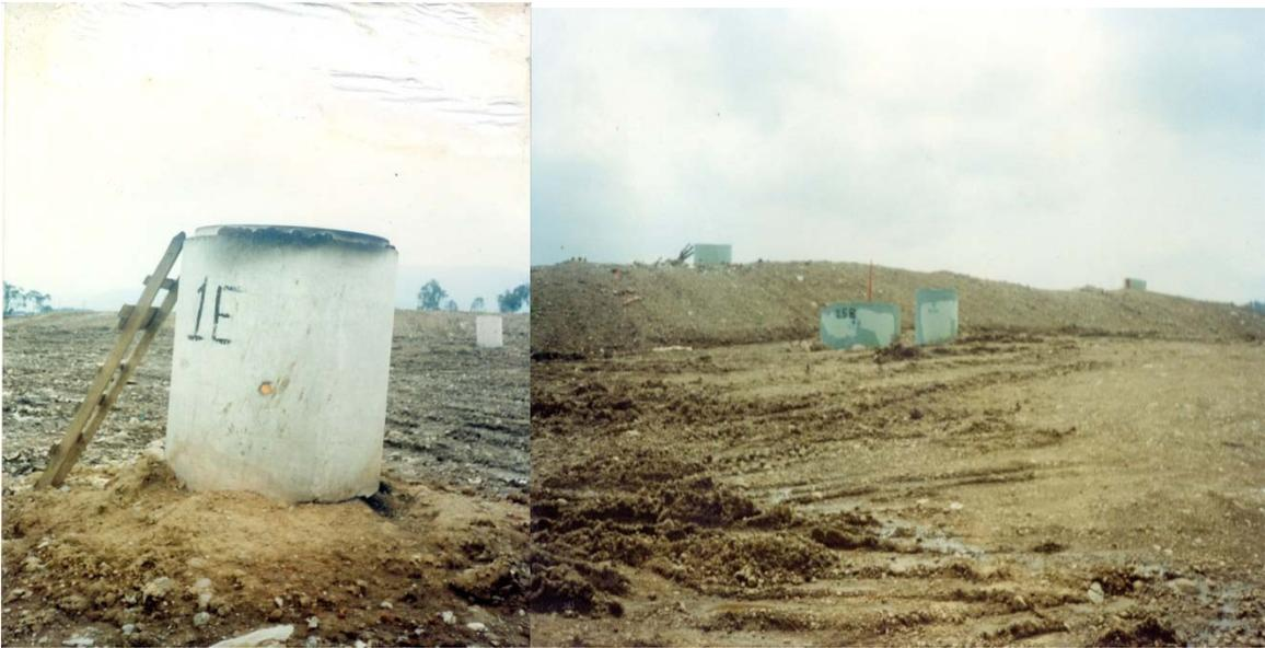
Figura II.7.a) Los cubos de concreto, son los pozos de venteo que se instalaron al cierre del relleno (1992). En el pozo de la izquierda, se observa que se está quemando el biogás.
