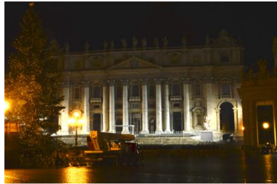
Ilustración 1- 11 Basílica de San Pedro apagada por cambio de luminarias, solamente iluminada por las luces de la plaza Fuente: AOA
