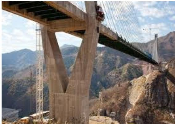
**Figura 3.-Mastil principal y superestructura, conformada por dovelas de concreto en los extremos y sección compuesta dentro del claro principal.**
