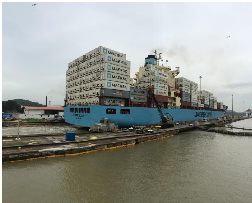
Figura 3.6 Barco portacontenedores en el Canal de Panamá
