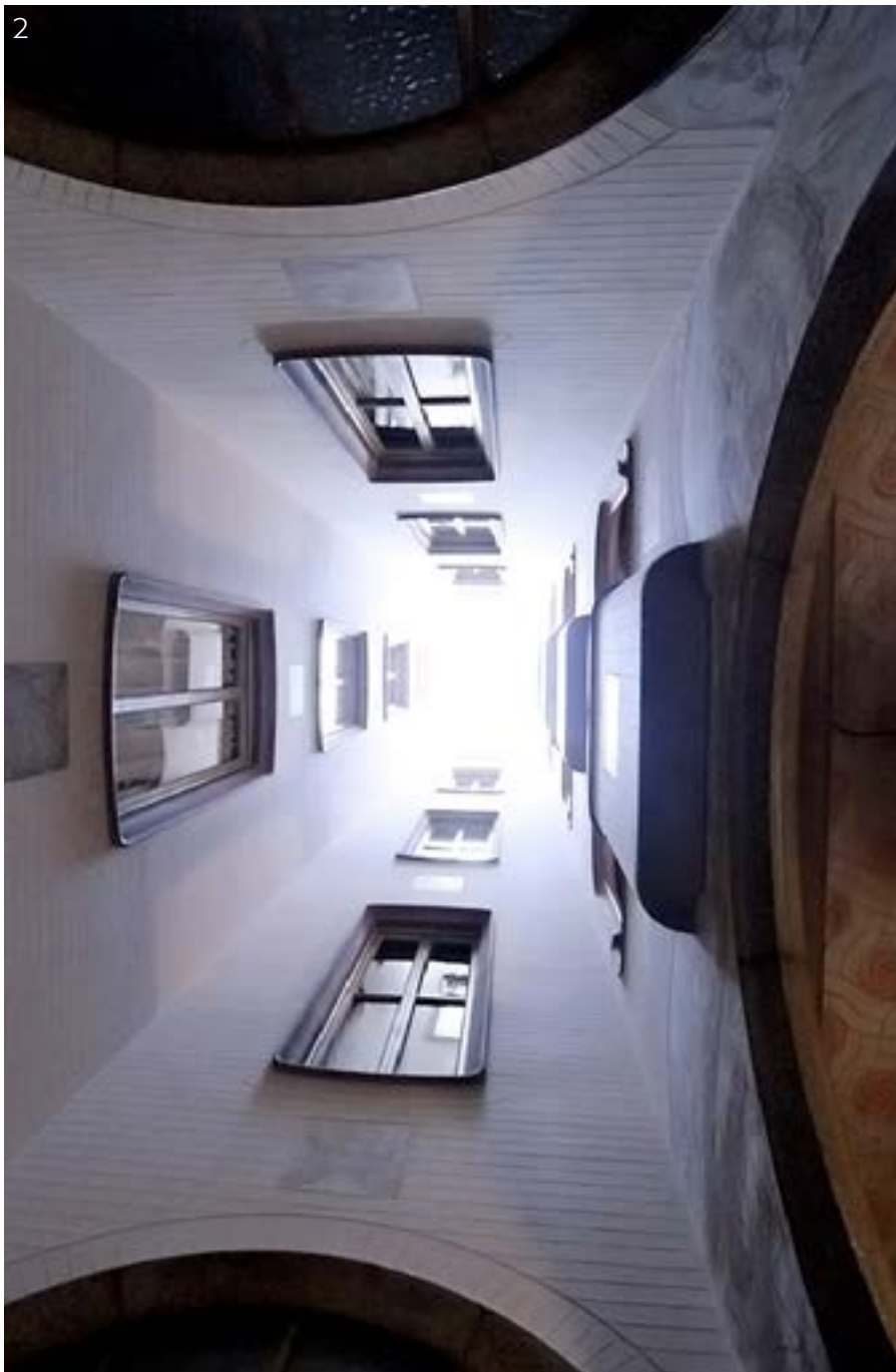
IL. 2: VISTA EN CONTRAPICADA DE UN CUBO DE ILUMINACIÓN DE CASA CALVET
