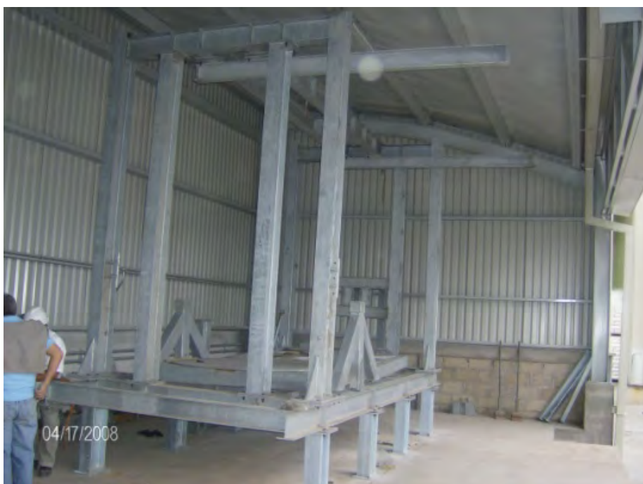
Figura 4.44. Colocación de las columnas centrales y de izaje.
