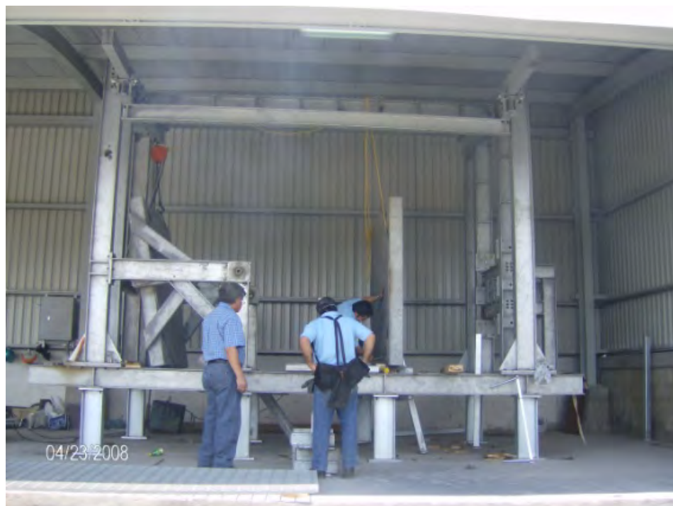
Figura 4.47. Colocación del marco deslizante.
