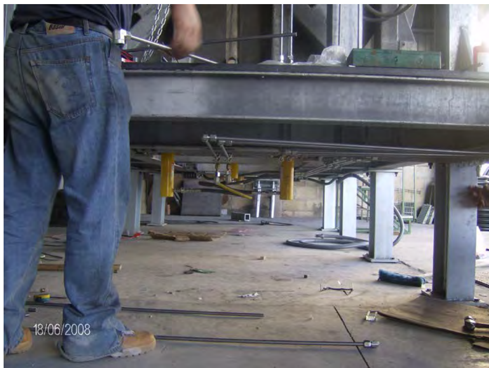
Figura 4.48. Colocación de la línea de potencia de los cilindros hidráulicos.
