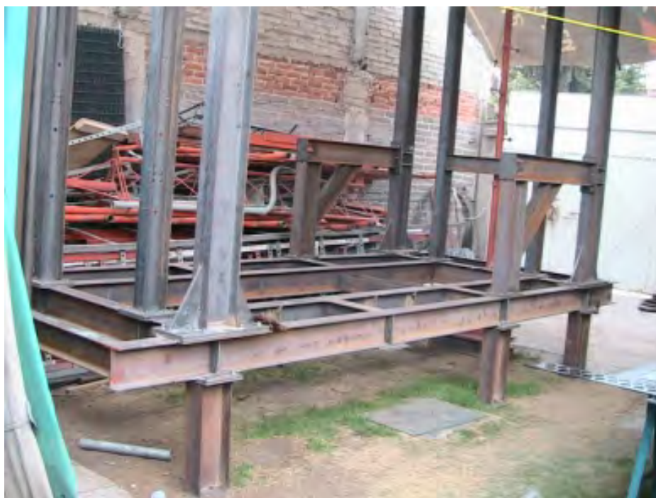
Figura 4.15. Armado estructural EPH-60.
