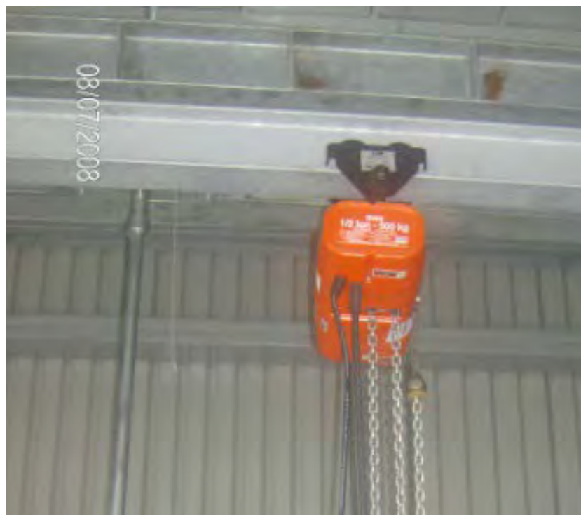
Figura 4.58. Sistema de izaje.
