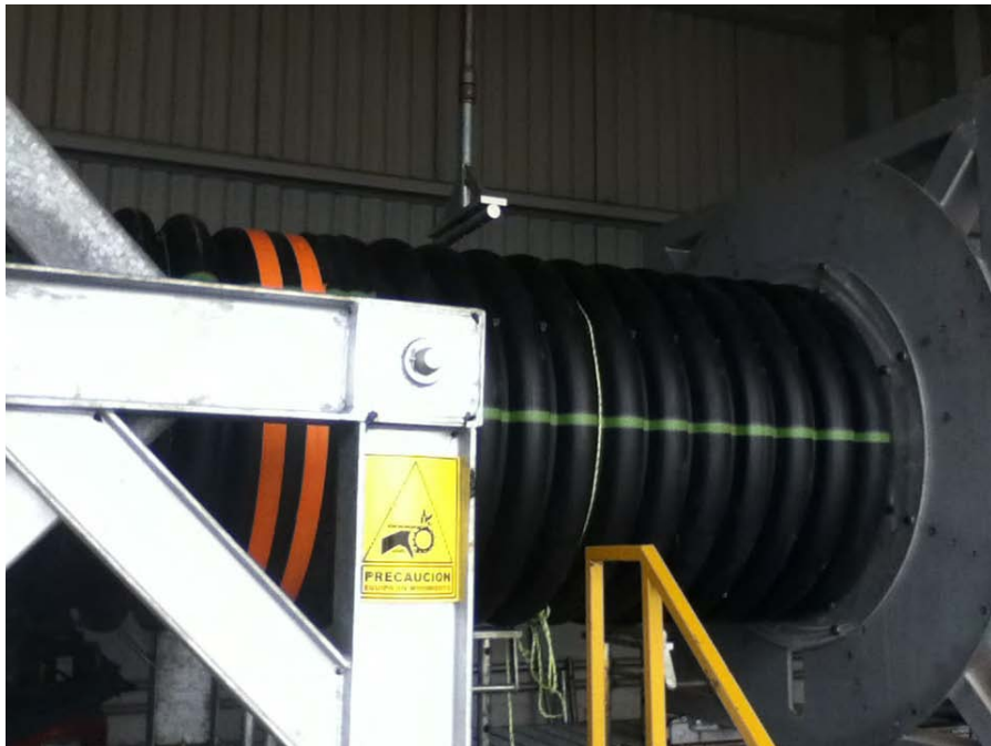
Figura 4.76. Prueba de hermeticidad a tubería de 36 pulg.
