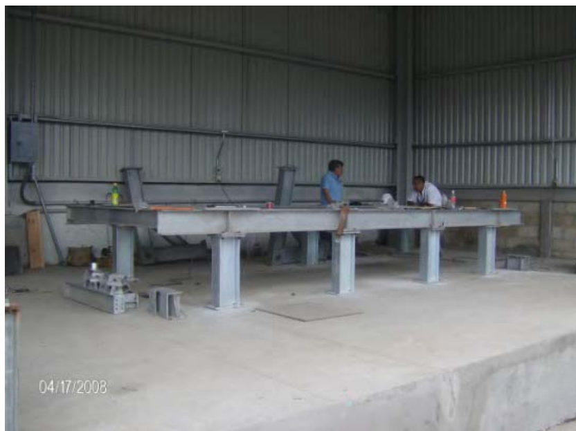
Figura 4.41. Colocación de soportes y de la base inferior.
