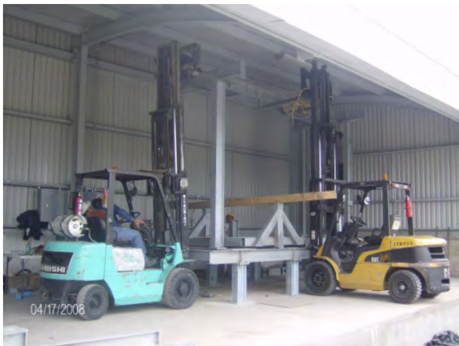
Figura 4.43. Colocación de la estructura superior.
