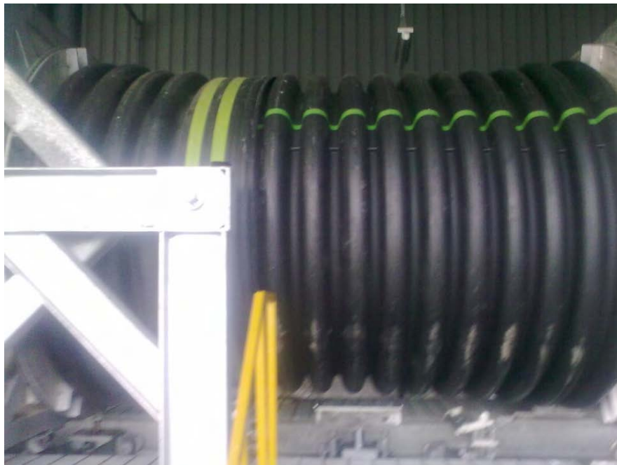
Figura 4.80. Imagen tomada de la unión de 60 pulg durante la prueba de vacío.
