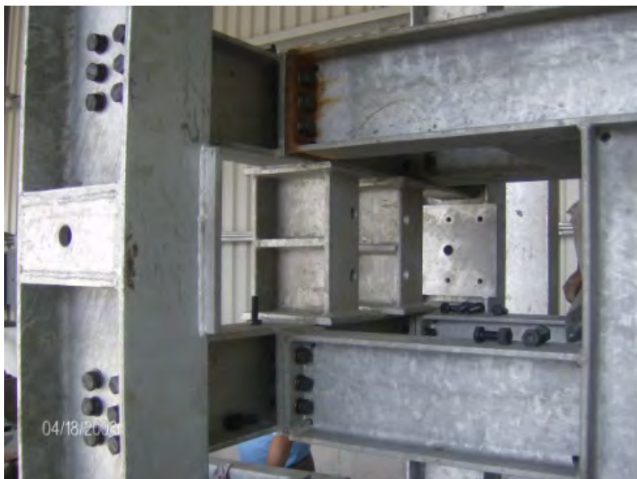
Figura 4.45. Colocación de la estructura base del motorreductor.
