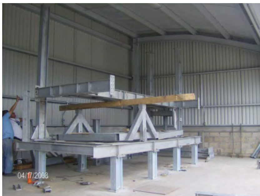
Figura 4.42. Colocación de la estructura superior.
