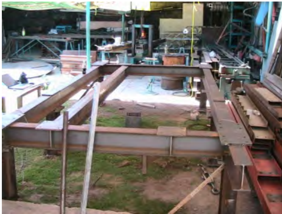
Figura 4.14. Base en construcción.
