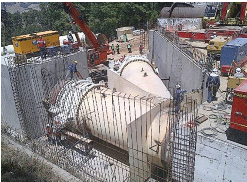
Figura 10. Obras de la línea de conducción
