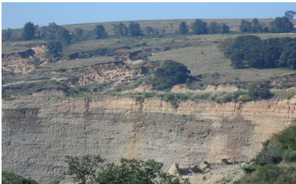
Figura 5.- En primer plano una cantera ubicada al NW de la localidad de Transfiguración, en la cual se observa la estratificación de los materiales que forman el piedemonte de la Sierra de Monte Alto – Monte Bajo. En segundo plano los procesos de acarcabamiento de la extensa rampa volcánico – detrítica de la Formación Tarango.
